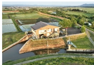
野谷地排水機場
