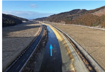
南沢川（護岸工）
