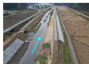
南沢川（築堤工，護岸工）
