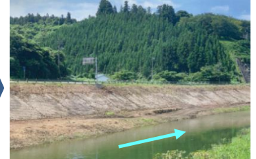
南沢川（支障木撤去後）
