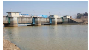
高鳥水門補修（旧迫川）
