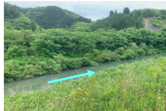
南沢川（支障木撤去前）
