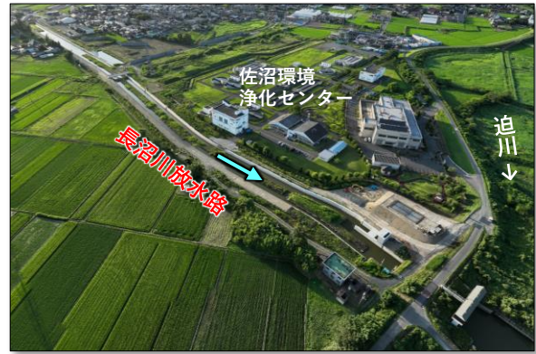
【長沼川放水路の整備状況】
