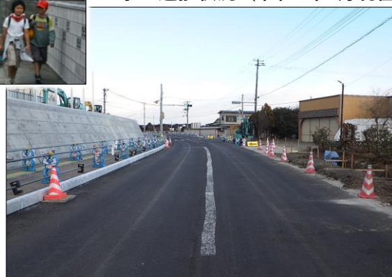
工事の進捗状況（令和6年2月現在）
