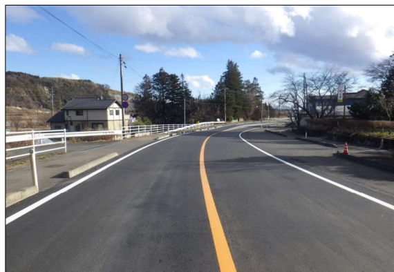
【補修後の状況】
