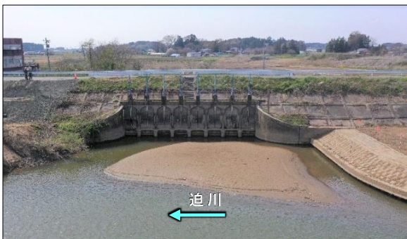
【山吉田水門・施工前の状況】
