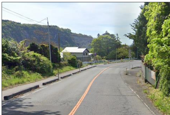
【補修前の状況】
