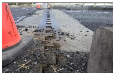
(国)398号 迫町北方 飯土井大橋 伸縮継手復旧
