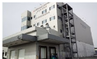
冷凍冷蔵施設
