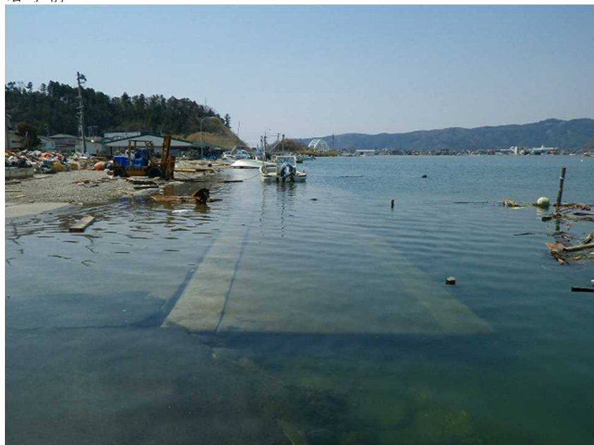
物揚場 着手前
