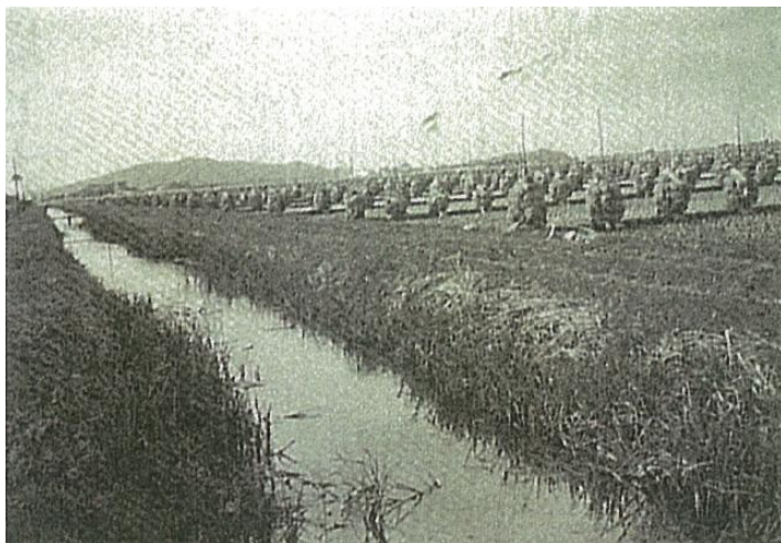
嘉衛門堀 (改修工事前)
