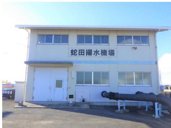
▲ 蛇田揚水機場
