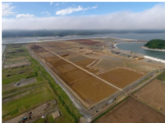
← 農地復旧工事が進められている長面工区
