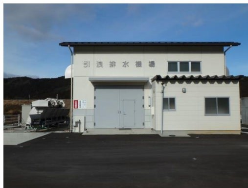
▲事業により整備を行った引浪排水機場
