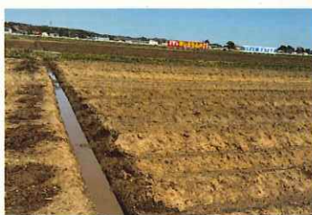
二重明渠の施工
