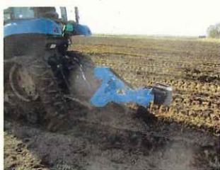
カットドレーンによる補助暗渠施工
