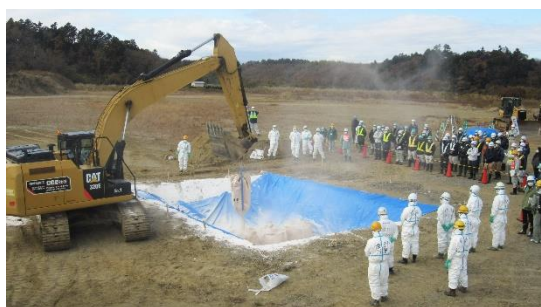
消石灰散布の演習の様子
