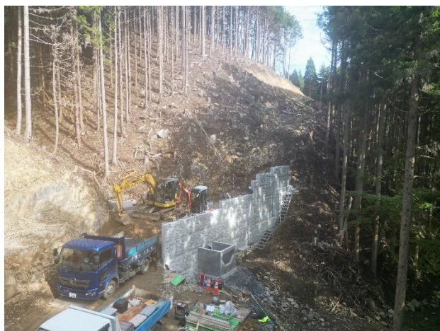
施工中の現場
