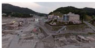
高台にある女川町立病院の1階に達した津波
