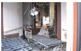
被災した高齢者施設(石巻市南浜)
