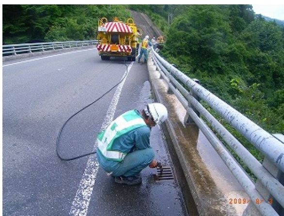
風越橋清掃状況
