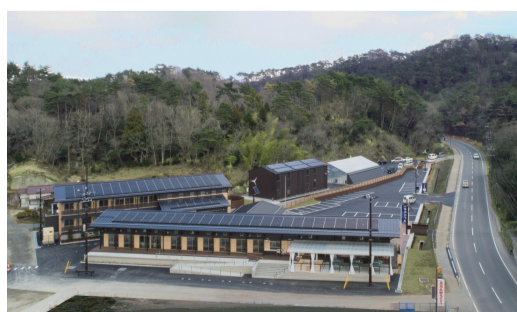
東松島市宮古地区に復興再生多目的施設『あおみな』が完成(提供:東松島市)
