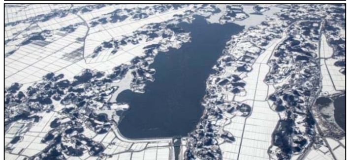
長沼ダム全景（試験湛水洪水時最高水位到達時）
