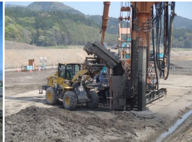
洗浄砂はサンドコンパクションパイル用 資材として利用
