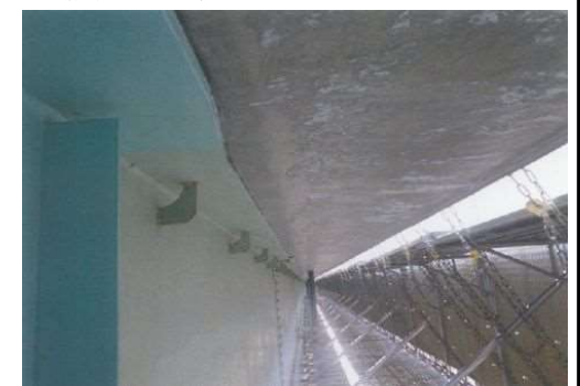
<整備後> 床板補修
