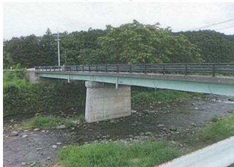
<整備後>防護柵取替，主桁塗装
