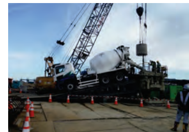
折立川河川災害復旧工事 「場所打ち杭コンクリート打設状況」
