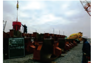
大谷地区海岸災害復旧工事 「消波ブロックコンクリート打設状況」
