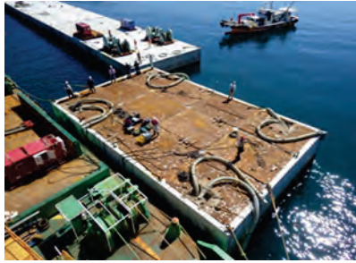
ケーソン据付
