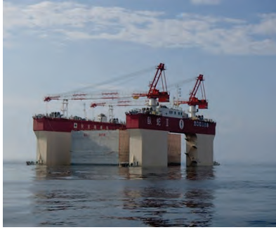
ケーソン進水
