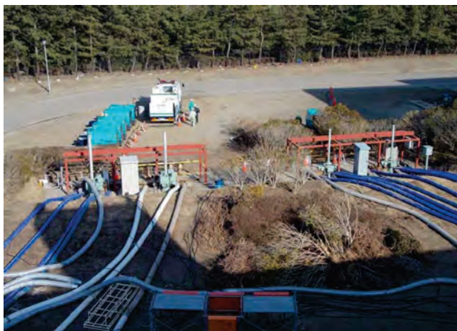
図 3-77 仮設ポンプ設置状況（仙塩浄化センター）
