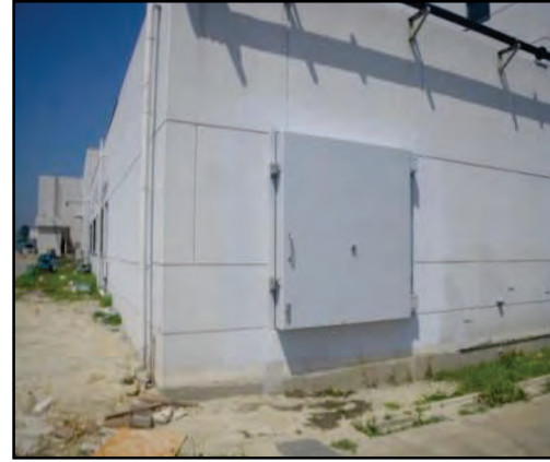
図 3-91 施設出入口を耐水扉とした津波対策（耐水化）【県南浄化センター】
