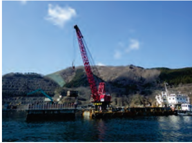
上部コンクリート打設
