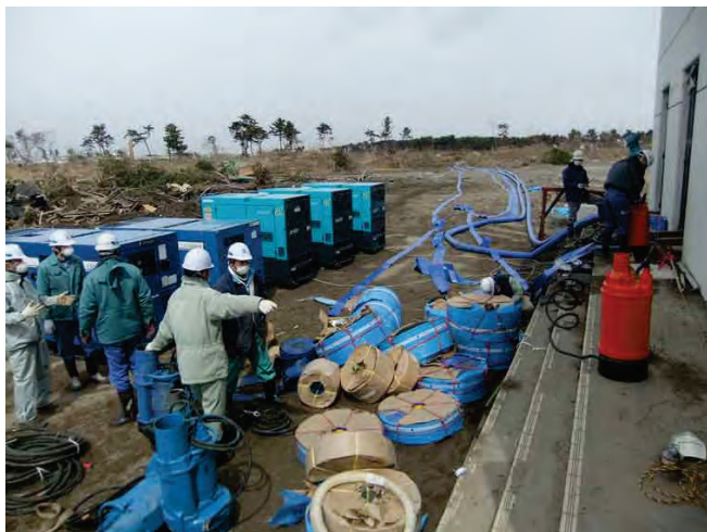
図 3-79 作業状況（県南浄化センター）
