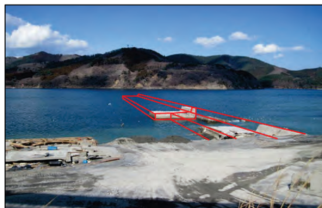
図 3-52 ケーソンが流出した南北防波堤
