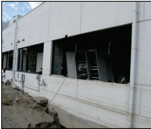
図 3-90 ポンプ場の窓閉鎖による津波対策（耐水化）【県南浄化センター】
