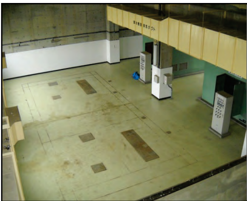
図 3-92 電気設備を2Fへ移動したことによる津波対策（高層化）【石巻東部浄化センター】
