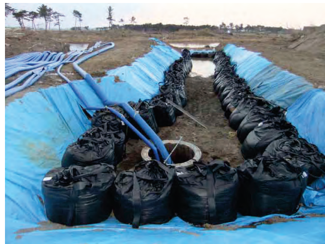
図 3-80 緊急排水状況（県南浄化センター）
