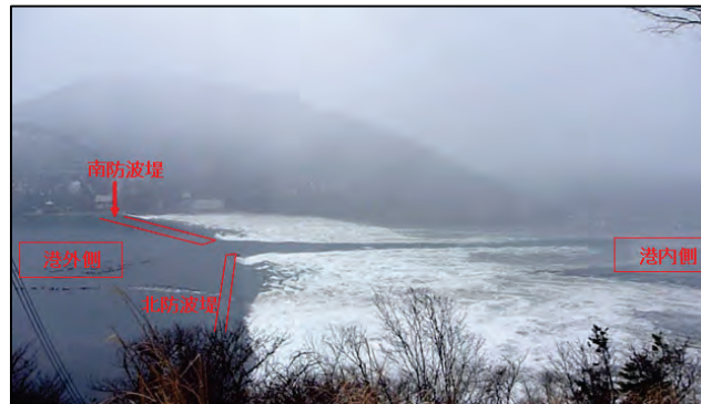
図 3-51 3月11日 津波襲来後の引き波の様子（南防波堤側から）
