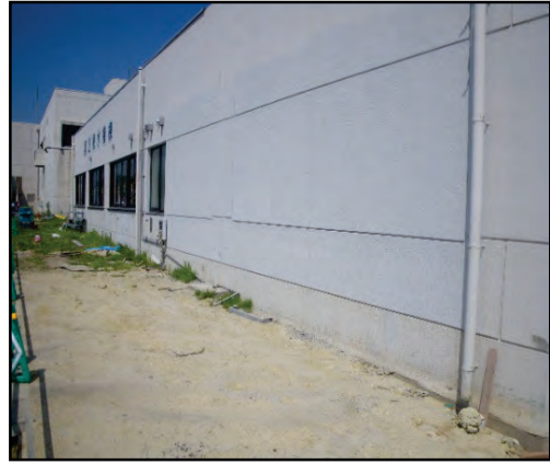
図 3-90 ポンプ場の窓閉鎖による津波対策（耐水化）【県南浄化センター】
