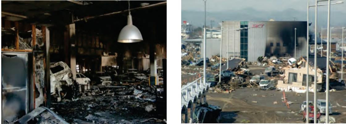
図 3-60 保税蔵置場（浸水した車両から引火し全焼）と施設全景
