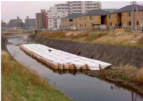
図 3- 85 要害川 仮設沈澱池
