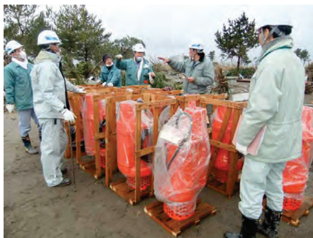
図 3-78 作業状況（県南浄化センター）
