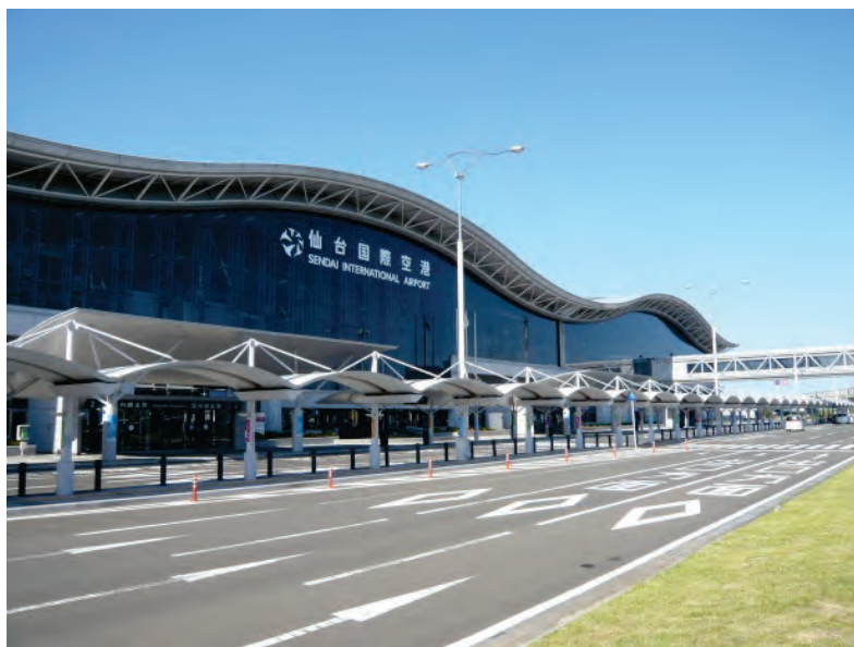
図 3-69 民間運営を開始した仙台国際空港
