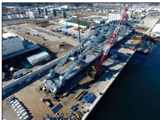
図 3-17 大島架橋上部工 地組状況
