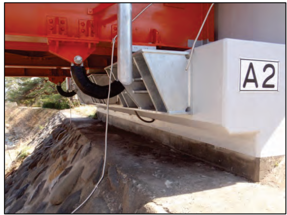
図 3-21 国道 457 号 遠刈田橋
