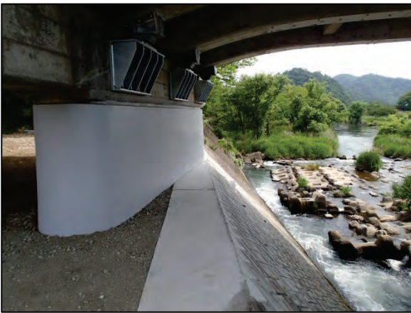
図 3-20 (主)岩沼蔵王線 宮大橋
