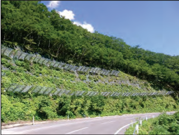
図 3-18 国道 347 号 外川工区雪崩防止柵
