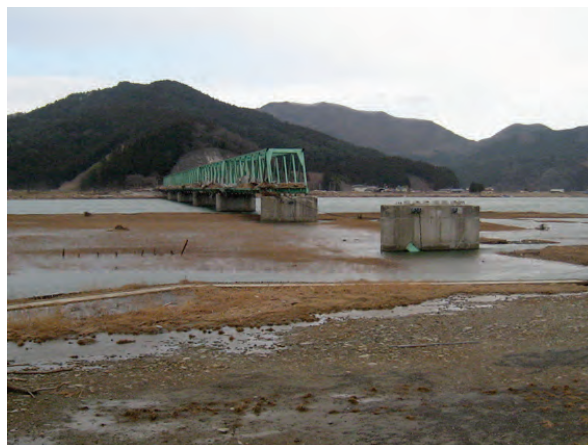
図 3-6 国道 398 号 新北上大橋の落橋 (黄色), 河北桃生線 北上川堤防上の道路が流出 (赤色)
