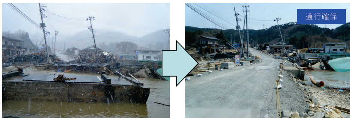
図 3-4 石巻鮎川線 十八成浜地区
