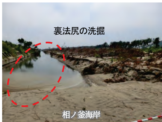
図 2-17 海岸堤防の被災事例
