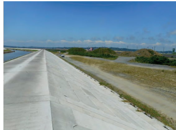
図 2-19 河川堤防の復旧事例（北上運河）
