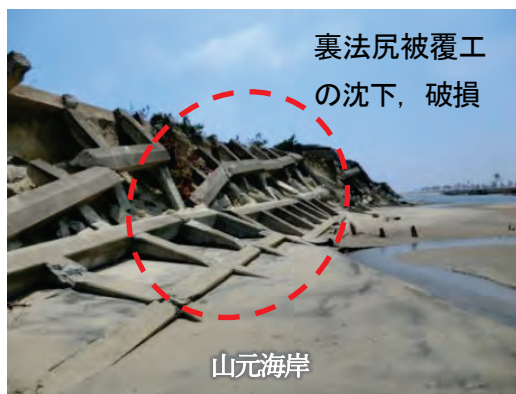
図 2-17 海岸堤防の被災事例
