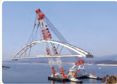
① 大島架橋 気仙沼市 (H29.3架設完了)
