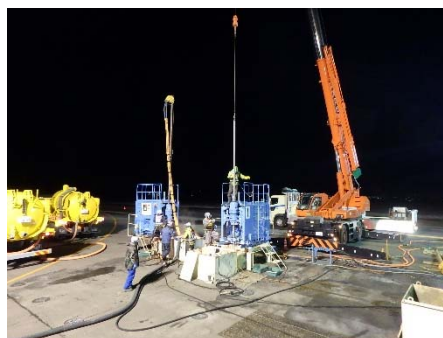
耐震対策工事の施工状況
