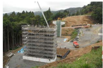
(主)石巻鮎川線 風越Ⅱ工区 (石巻市)
