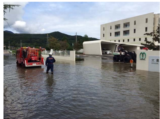
平家川(白石市)周辺の浸水状況
