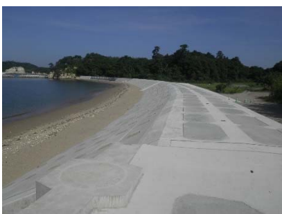
仙台塩釜港 (塩釜港区・寒風沢前浜地区)
