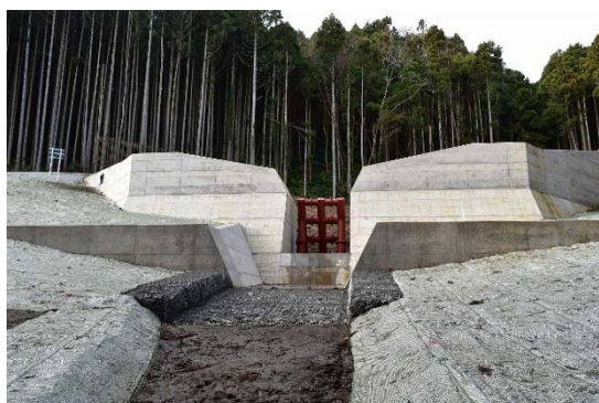
川畑沢砂防堰堤完成 (涌谷町)
