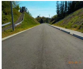
(国)346号 錦織工区 (石巻市)
