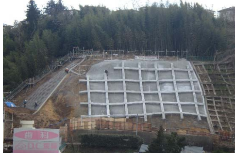
羽黒町急傾斜地 (石巻市)
