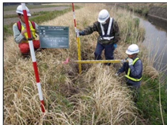
堤防点検(イメージ)
