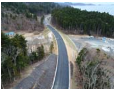
(主)石巻鮎川線 小網倉浜工区 (石巻市)
