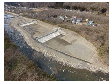
松川流路工事の完成（蔵王町松川）
