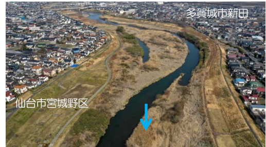
七北田川（築堤（堤防嵩上げ））
