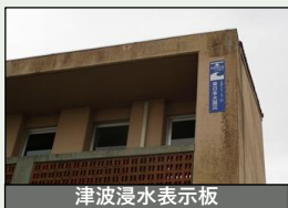
津波浸水表示板
