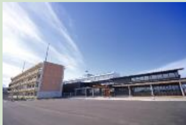
気仙沼市東日本大震災遺構・伝承館 (提供：気仙沼市東日本大震災遺構・伝承館)
