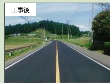
内陸部の舗装補修事例 (国)113号
