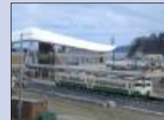
運行が再開された石巻線 (女川駅)
