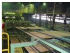
復旧した合板工場
