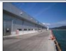
復旧工事が進められている 石巻魚市場
