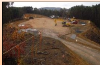
桐ヶ崎地区造成工事状況 (女川町)
