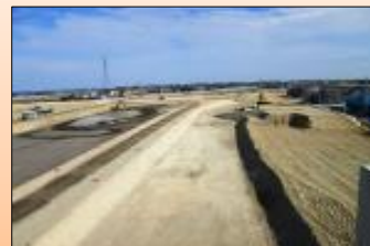
新山下駅周辺地区工事状況 (山元町)
