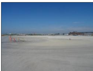
焼却炉解体後の状況 (石巻ブロック)
