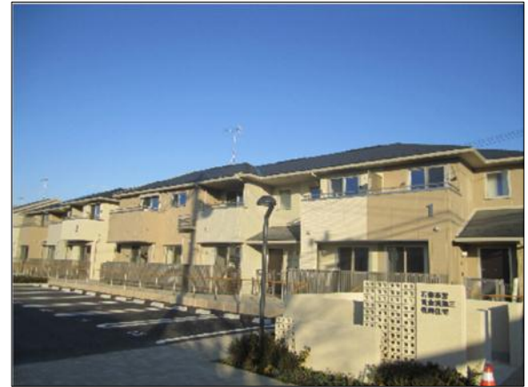
災害公営住宅整備状況 (石巻市黄金浜南地区)
