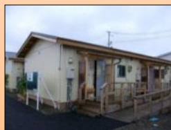
プレハブ仮設住宅(名取市)
