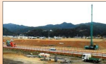
鹿折地区造成工事状況(気仙沼市)
