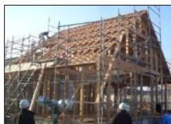
県産材を利用した 災害公営住宅
