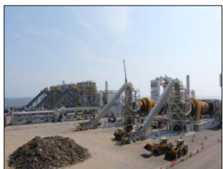
焼却炉稼働時の状況 (石巻ブロック)
