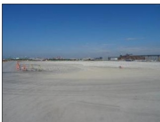
焼却炉解体後の状況 (石巻ブロック)
