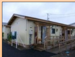
プレハブ仮設住宅(名取市)
