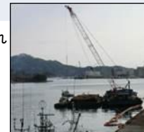
復旧工事が進められている気仙沼港
