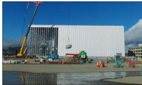
焼却炉解体のための覆い作業 (気仙沼ブロック) (平成26年1月 気仙沼市)
