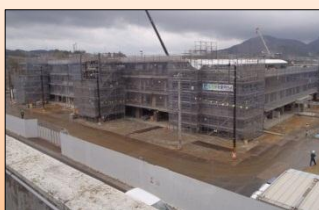
女川中心部地区 災害公営住宅建設状況 (女川町)
