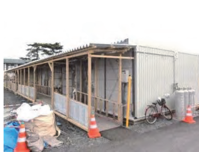
スロープ下屋
