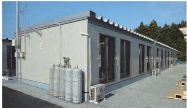
[写真：住宅部会のプレハブ仮設住宅]
