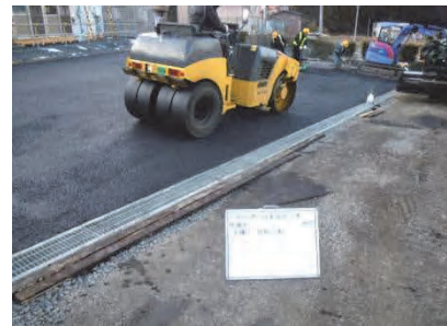
舗装・排水工事
