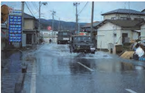
[写真：地盤沈下した県道（石巻市渡波地区）]
