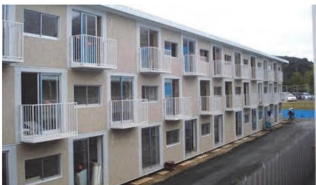
[写真：コンテナを利用した多層型応急仮設住宅 女川町運動公園野球場地区]
