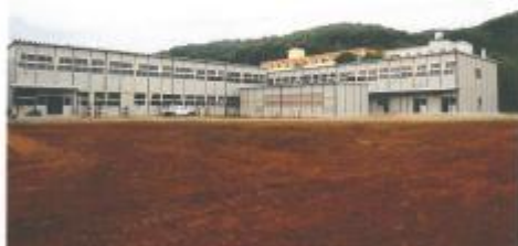
宮城県農業高等学校仮設校舎
