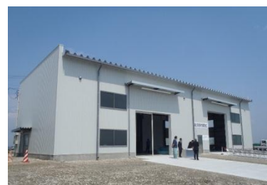
開設した関上仮設魚市場
