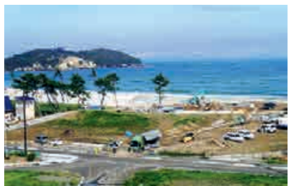
写真:葛蒲田浜海浜公園堤防工事の様子(七ヶ浜町)
