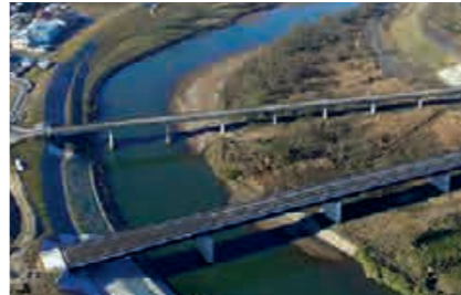
写真:新・志田橋(大崎市)
