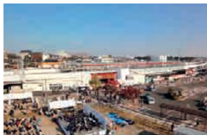
写真:多賀城駅周辺再開発(多賀城市)
