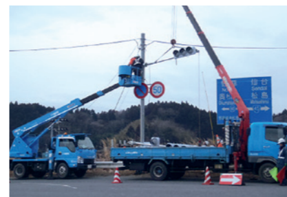
写真:信号灯器のLED化改良
