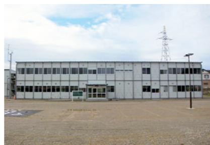
写真:気仙沼警察署仮庁舎
