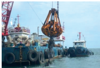
写真: 漁場ガレキ撤去作業
