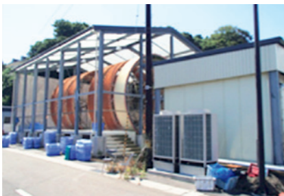
写真: ノリ陸上採苗施設の復旧(塩釜市浦戸桂島)
