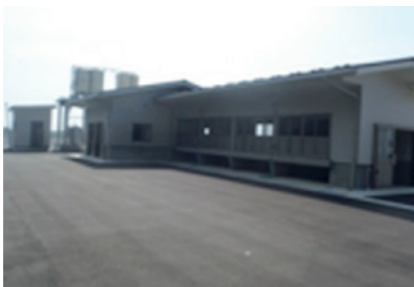
写真: カキ共同処理施設の復旧
