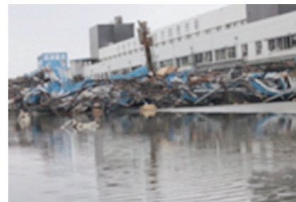
写真: 石巻市魚市場被災状況(平成23年度)
