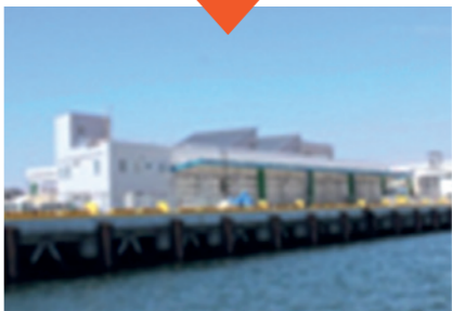
写真: 塩釜市漁市場完成状況(平成27年度)
