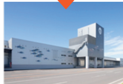
写真: 石巻市魚市場完成状況(平成27年度)
