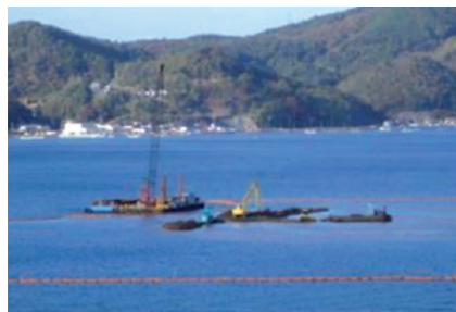
写真: 造成工事の様子(石巻湾地区)
