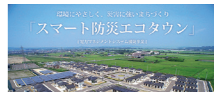
写真:スマート防災エコタウン(東松島市)
