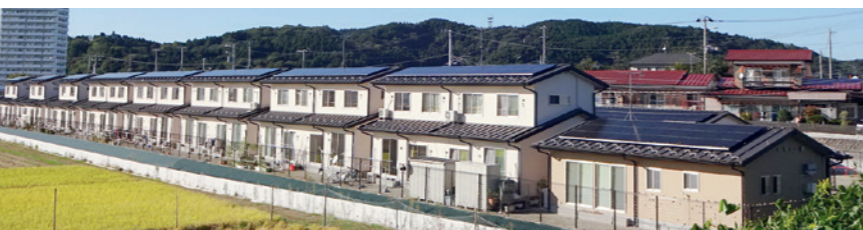
写真:災害公営住宅の屋根貸しによる太陽光発電(利府町)
