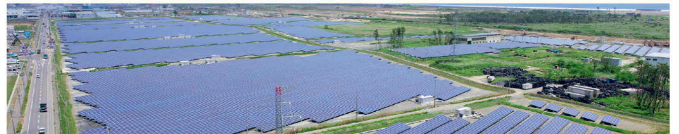
写真：メガソーラーの設置事業(岩沼市)
