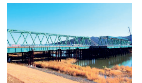
写真:新北上大橋 災害復旧工事(石巻市)
