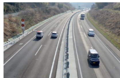
写真:4車線化した仙台松島道路
