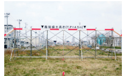
写真：門脇流留線 丁張設置(石巻市)
