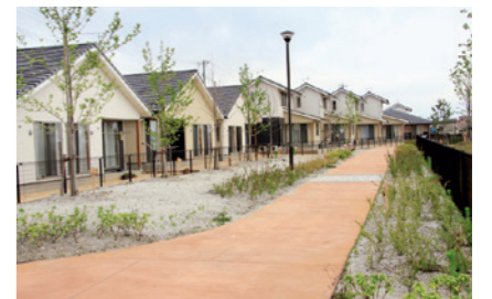
写真：防災集団移転を実施した地区(岩沼市)
