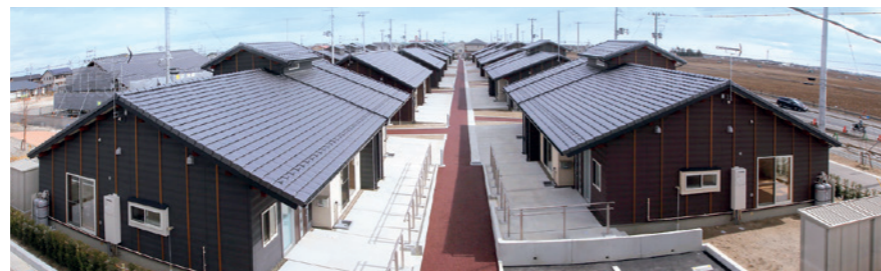
写真：集団移転によって生まれたまち(岩沼市)
