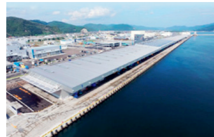
写真:石巻魚市場(平成27年9月 全面供用開始)
