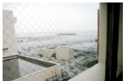
写真:石巻東部浄化センターに押し寄せる津波(石巻市)
