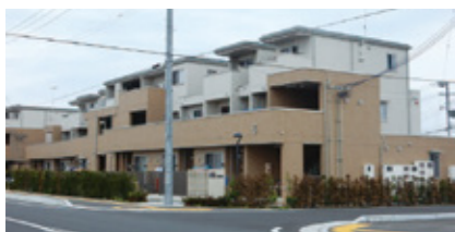
写真:石巻市新立野第2住宅(石巻市)
