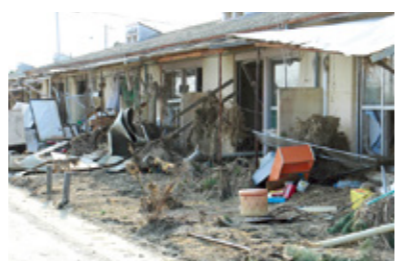
写真:津波被害を受けた市営立沼住宅(東松島市)
