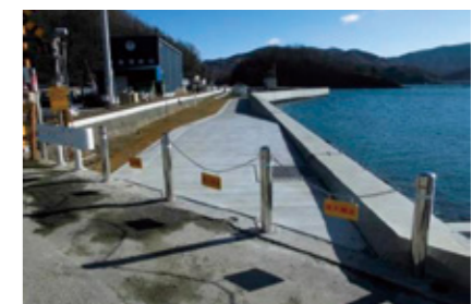
写真:万石浦地区海岸高潮対策工事(石巻市)
