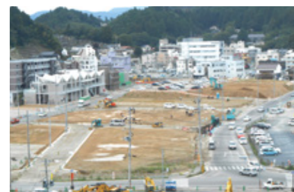
写真:魚町・南町地区盛り土かさ上げの様子(気仙沼市)
