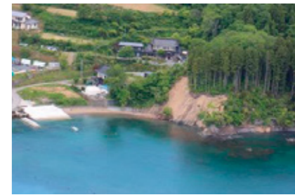
写真:三陸リアスの森保全対策事業実施海岸地荒廃対策工事計画箇所(気仙沼市)
