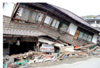
写真:倒壊した家屋(気仙沼市)
