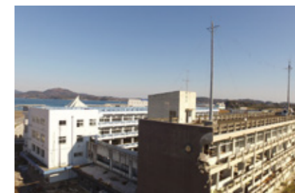
写真:震災遺構(気仙沼向洋高等学校旧校舎)(気仙沼市)
