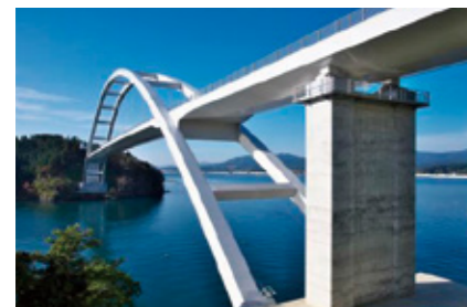
写真:気仙沼大島大橋(気仙沼市)
