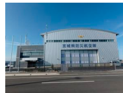
写真:宮城県防災ヘリコプター管理事務所完成
