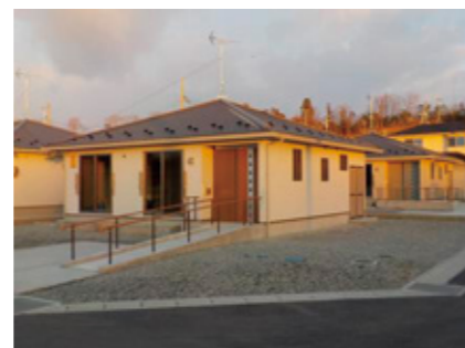
写真:災害公営住宅(山元町宮城病院周辺地区)
