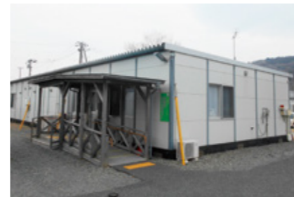
写真:宮城県東部被災者転居支援センター(外観)
