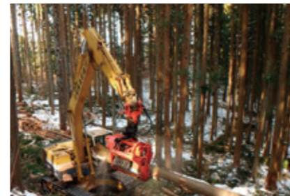
写真:間伐作業中
