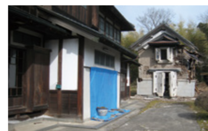
写真:村田町(豪農の館)
