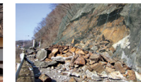
写真:川崎町(がけ崩れが発生した道路)
