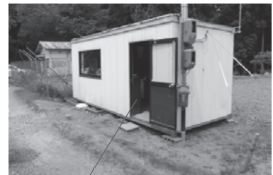
応急仮工事で、水質検査室を設置→
