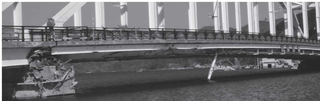
津波により破断した送水管
