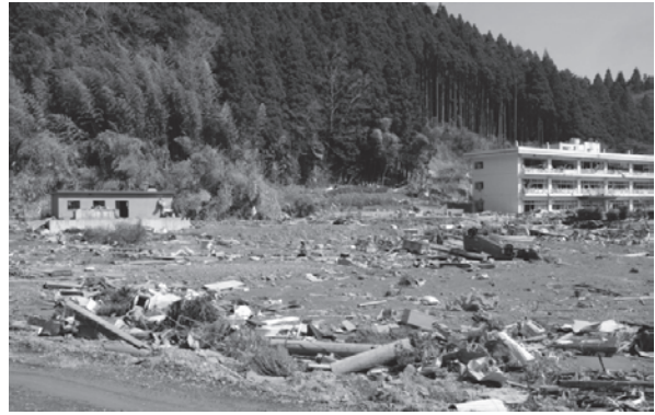
相川浄水場（左側・ピンクの建物） 相川小学校（右側・白い建物）被災状況
