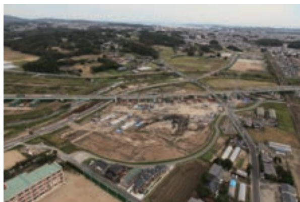
写真5-31 山王遺跡・市川橋遺跡
