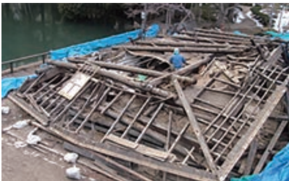
写真 5-10 屋根の解体作業
