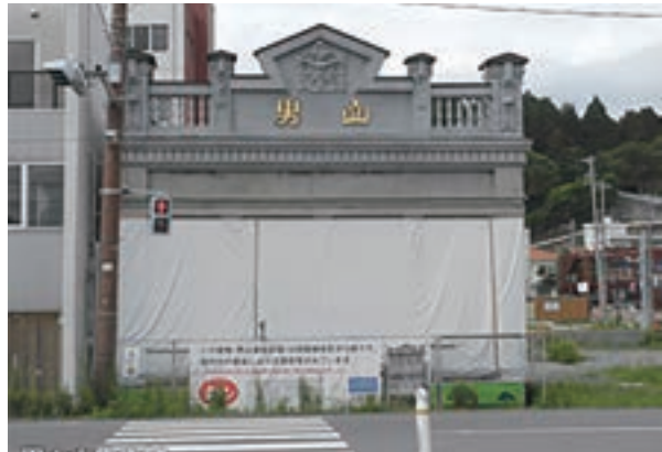
写真 5-16 シートで保護されたままの状態
