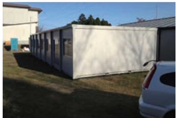
写真 6-8 仮保管のために設置された収蔵施設
