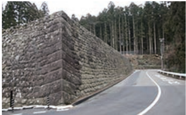
写真 5-8 完全復旧した石垣
