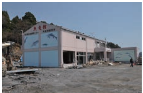
写真 3-32 水没した水産振興センター
