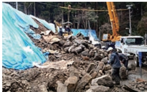
写真 5-6 崩壊した石を記録をして移動
