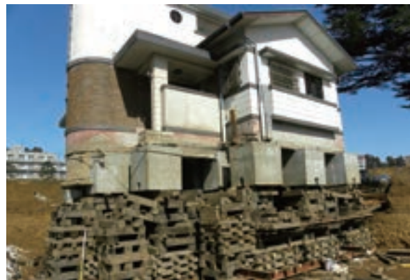
写真 3-6 荒巻配水所旧管理事務所
