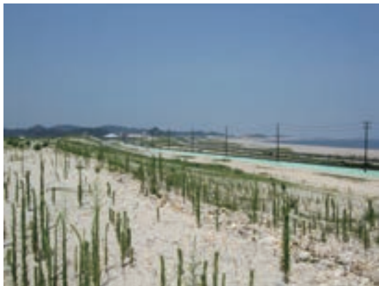
写真 5-21 東松島市野蒜海岸の防災林盛土
