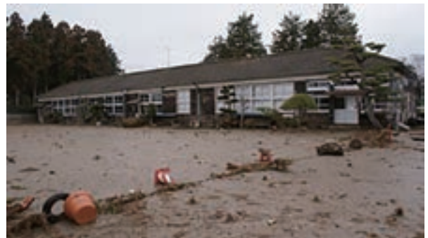
写真 3-31 津波被害を受けた下野郷学習館
