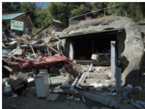
写真3-12 瓦礫が押し寄せた岩屋
