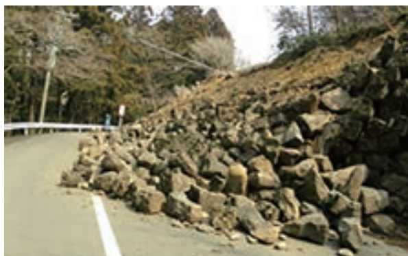
写真 5-5 地震により崩壊した石垣
