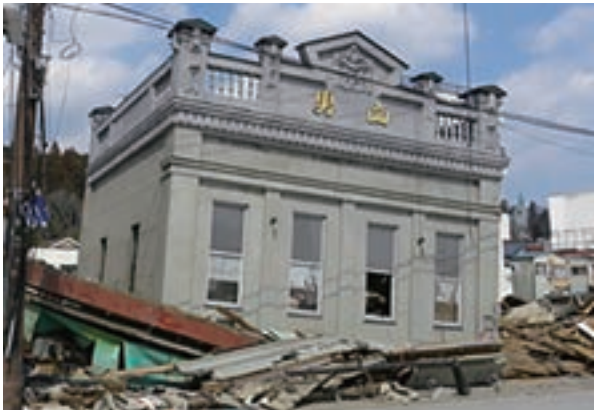
写真 5-15 2階部分が倒壊した男山本店
