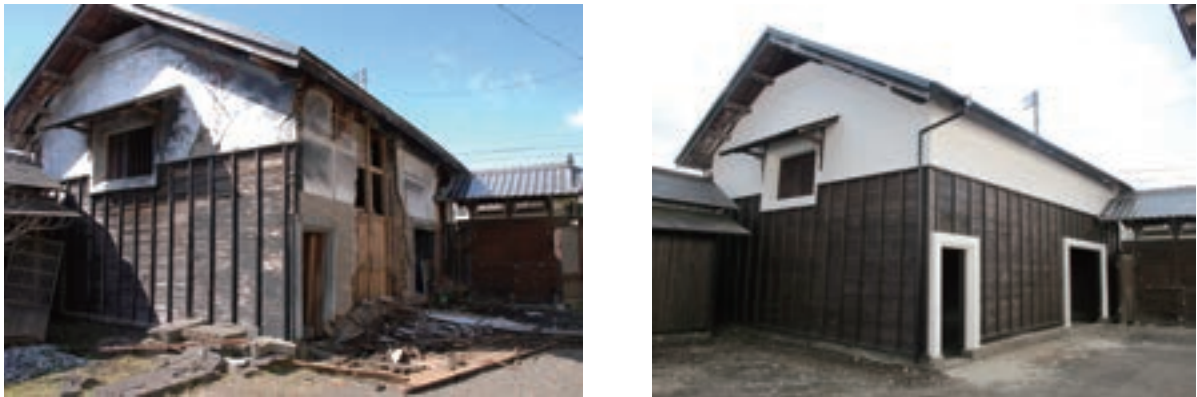
写真 6-6 文化財ドクター派遣事業により保存が図られた文化財建造物
