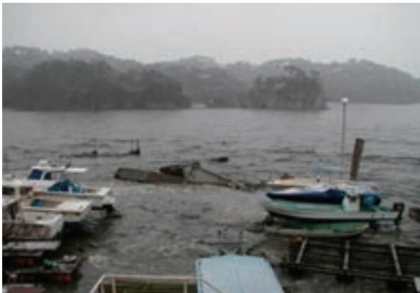
写真 3-20 浜田漁港 (津波浸水)
