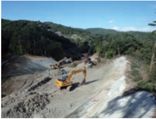
写真 5-23 利府町の避難道路建設
