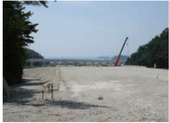
写真 5-24 東松島市の JR 仙石線高架橋
