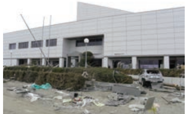
写真3-27 津波が引いた後の石巻文化センターの外観
