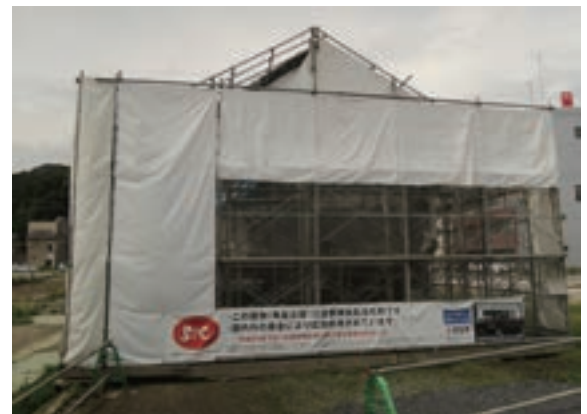
写真 6-19 角星店舗の修理に向けて（気仙沼市）
