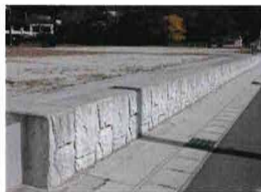
浜田漁港堤防の表面処理
