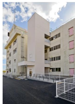
エレベーター棟
