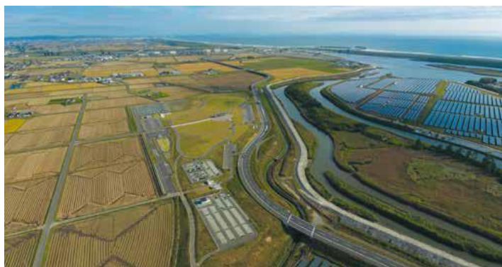
南側から閑上地区を望む
