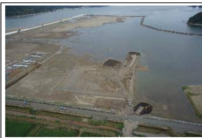
左：復旧前の湛水の状況（平成 28 年 6 月）
