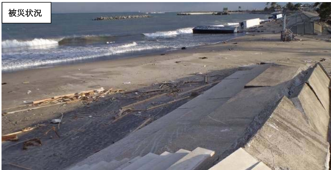
応急復旧状況
