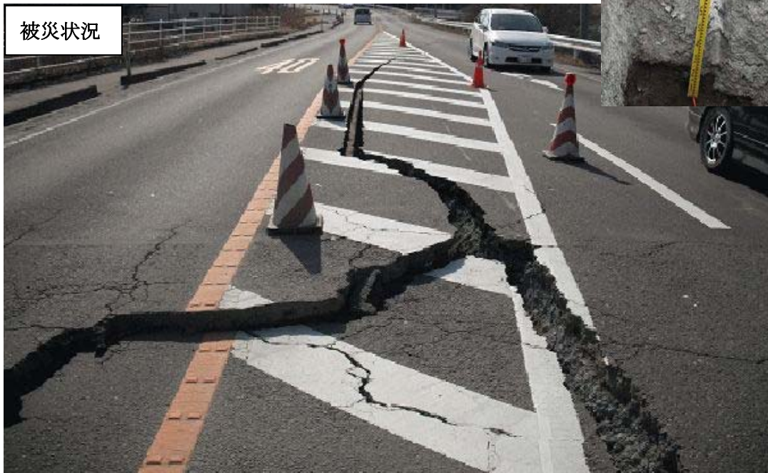
深さ 1.6m以上に達した亀裂
