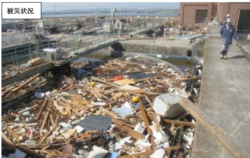
応急復旧状況（瓦礫撤去）
