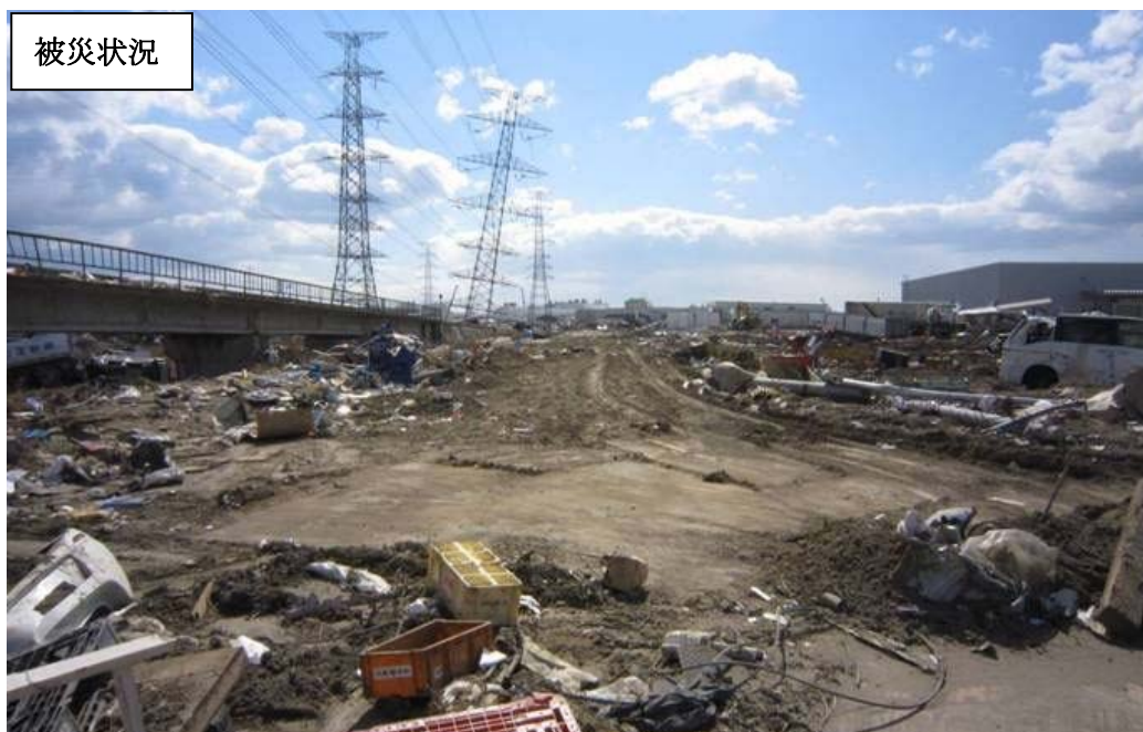
応急復旧状況
