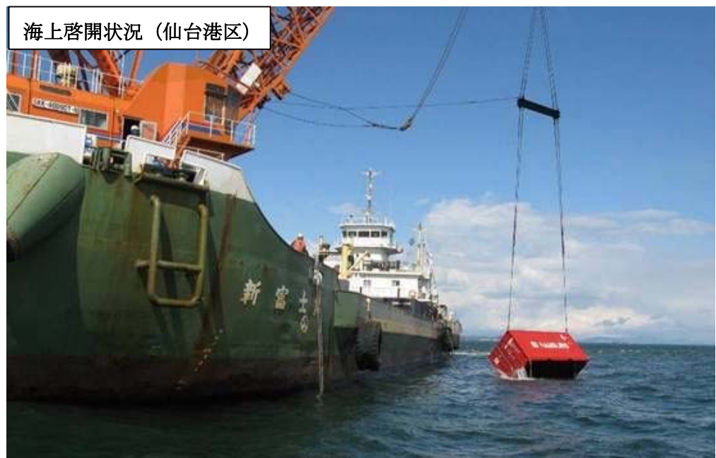
海上啓開状況（仙台港区）
