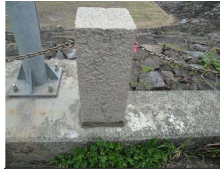
写真-2 荒砥沢ダム防護柵復旧状況
