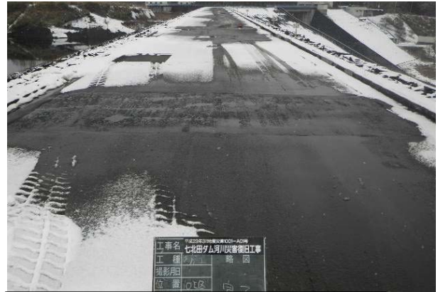
写真-4 七北田ダム本復旧工事完了の状況
