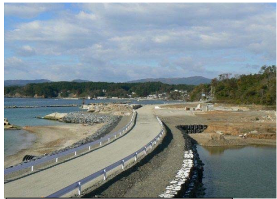
写真-17 長須賀地区海岸 応急工事
