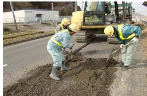
写真-2 (主) 鹿島台高清水線 応急対応の状況
