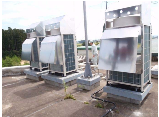
写真-4 化女沼ダム管理事務所 冷暖房設備の復旧状況
