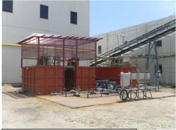
写真-4 仮設汚泥処理施設設置
