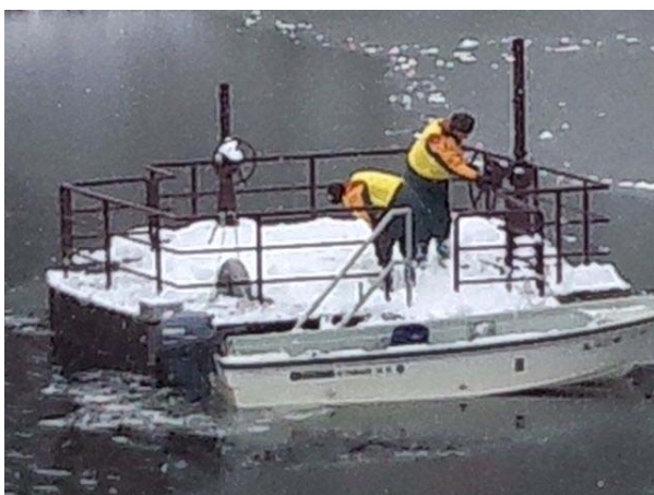
写真-5 上大沢ダム試験通水 取水塔制水ゲート全開操作
