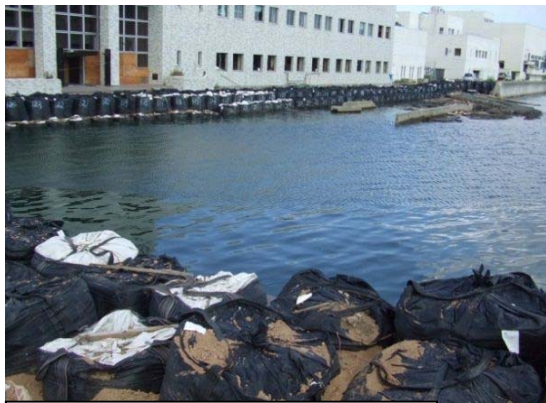
写真-14 二級河川大川 応急工事
