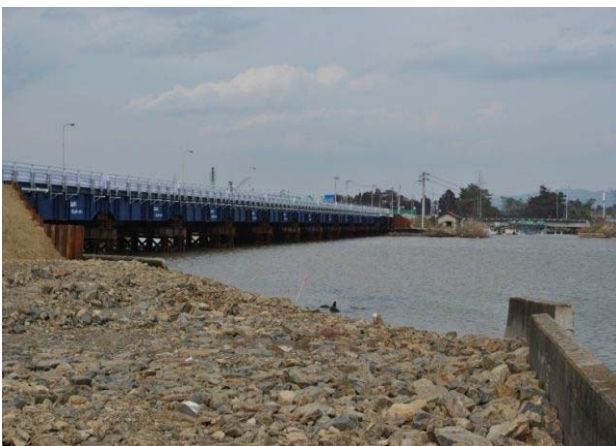
写真-11 定川大橋仮橋開通
