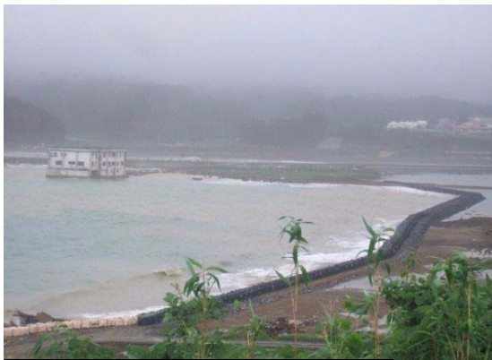
写真-16 中島地区海岸 応急工事
