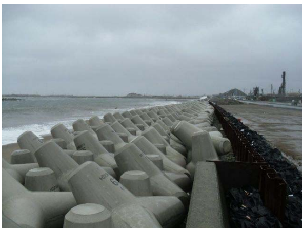
写真-5 東浜防潮堤応急対応の状況
