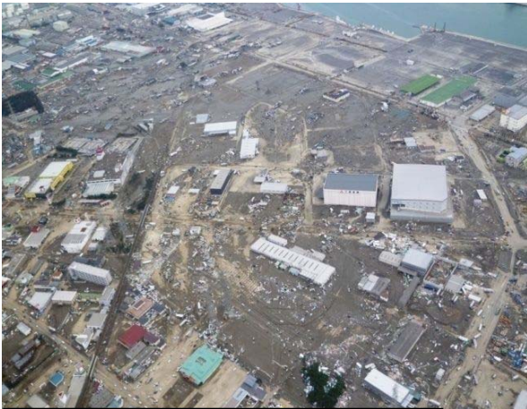
写真-1 工業地区の被災状況 H23.3.13
