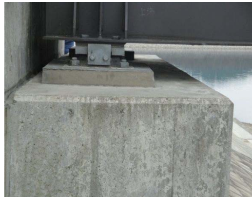
写真-4 小田ダム取水塔管理橋復旧状況
