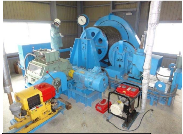
写真-2 北部土木事務所支援 災害現場調査（水門）の状況
