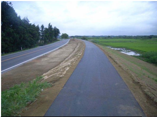
写真-3 迫川堤防本復旧工事の完了状況
