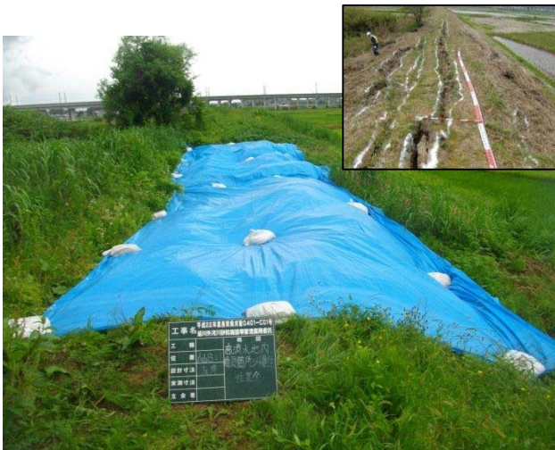
写真-3 小山田川の応急復旧状況
