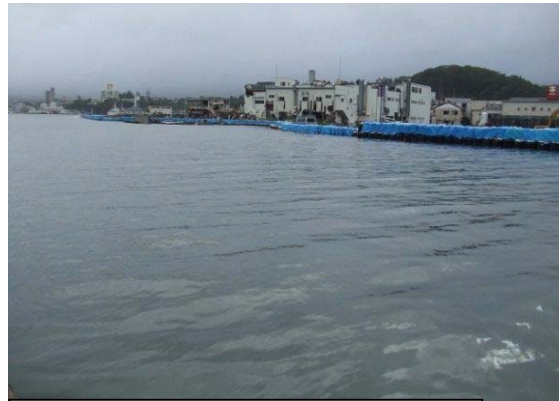
写真-15 二級河川 鹿折川 応急工事
