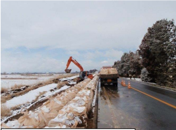
写真-1 迫川堤防応急対応の状況
