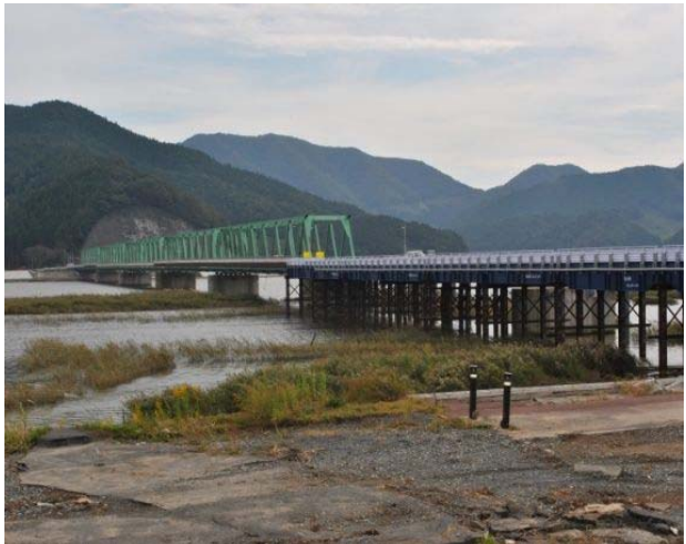
写真-10 新北上大橋仮橋開通
