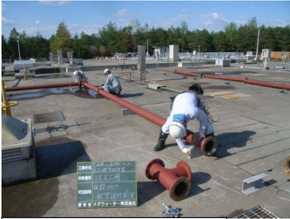
写真-3 簡易曝気設備設置状況
