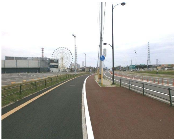
写真-6 復旧した都市計画道路 H24.1
