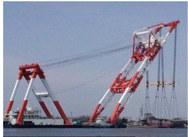
写真-4 サルベージ作業の状況
