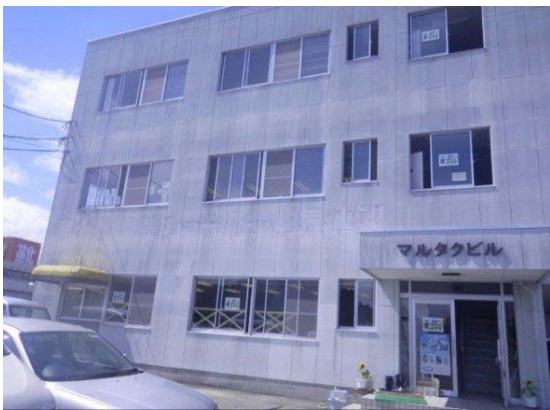
写真-3 仮庁舎 (マルタクビル) 外観
