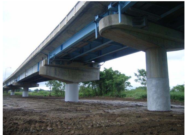
写真-4 豊里大橋本復旧工事の状況
