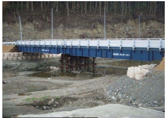
写真-6 折立橋仮橋完成
