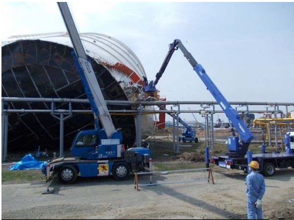
写真-5 被災施設撤去状況 (ガスホルダー)
