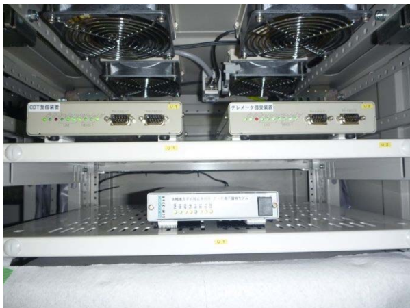
写真-3 化女沼ダムデータ表示装置 の復旧状況
