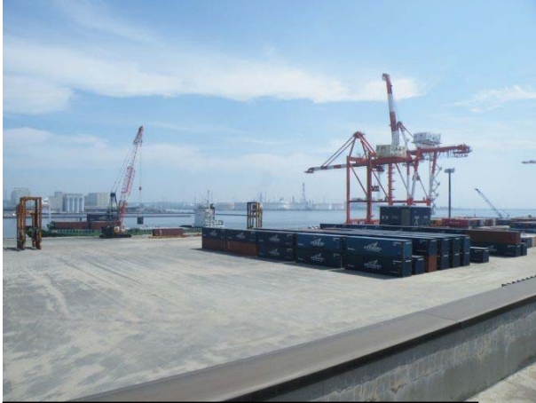
写真-1 H23.6.8 コンテナターミナル再開
