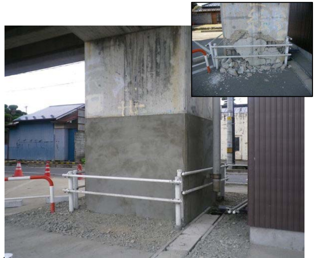
写真-4 川南高架橋の応急復旧状況
