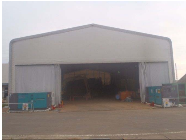
写真-6 仮設汚泥処理テント設置 (堆積汚泥処理)
