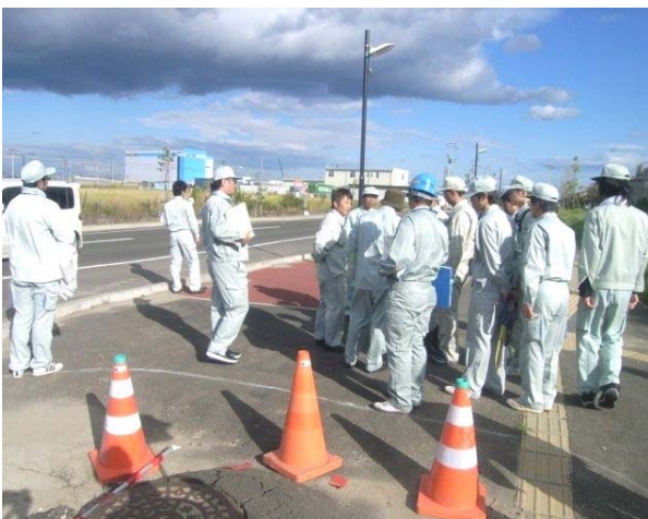
写真-5 災害査定状況 H23.10.3
