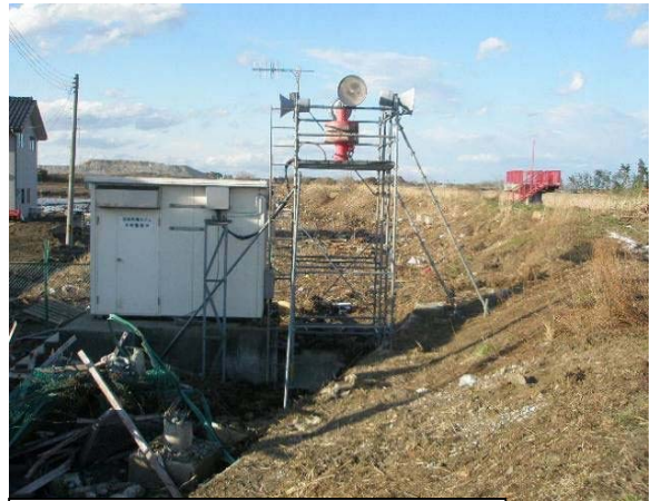
写真-2 寺野警報局応急対応完了
