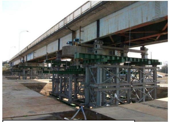
写真-2 豊里大橋応急対応の状況
