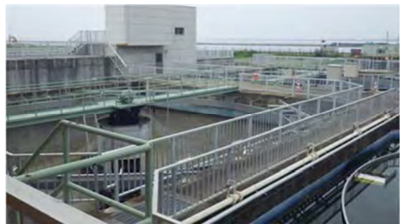
▲平成 26 年 3 月 26 日完成状況
