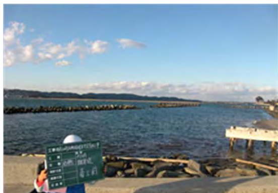
▲仙台塩釜港（塩釜港区） 代ヶ崎離岸堤
