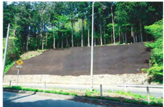
▲平成 25 年 5 月 30 日 本復旧完了
