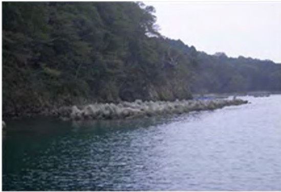
▲唐桑海岸 藤浜地区海岸 離岸堤(1) 沈下状況
