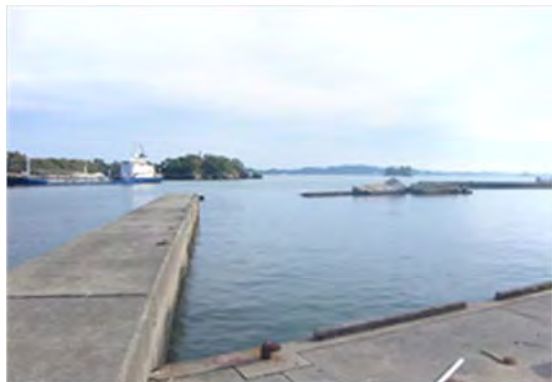
▲仙台塩釜港（塩釜港区） 代ヶ崎東防波堤
