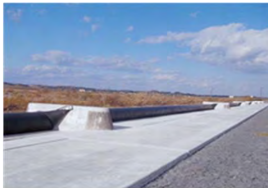
▲平成 25 年 11 月 29 日 本復旧完了
