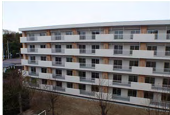
▲平成 25 年 12 月 20 日 建替工事完成
