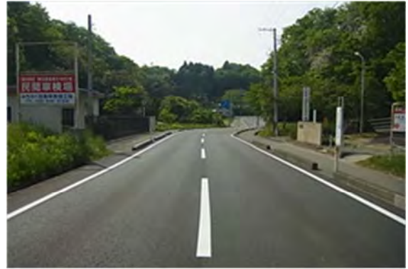
▲平成 25 年 6 月 18 日 本復旧完了
