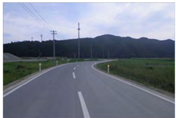
▲平成 25 年 9 月 30 日 完成 釜谷道路災害復旧工事
