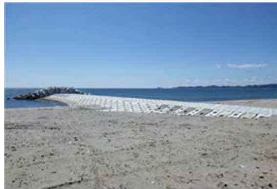
▲平成 25 年 12 月 11 日 本復旧完成
