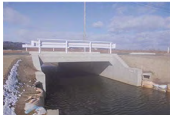
▲平成 26 年 2 月 19 日 本復旧完了
