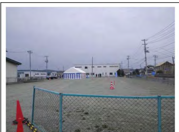
▲平成 25 年 3 月 12 日着工 東松島市鳴瀬給食センター跡地地区災害公営住宅
