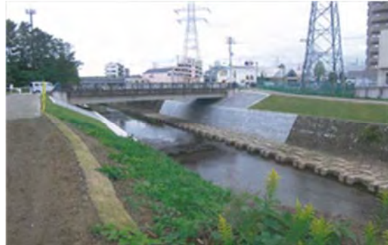
▲平成 26 年 2 月 21 日 本復旧完了
