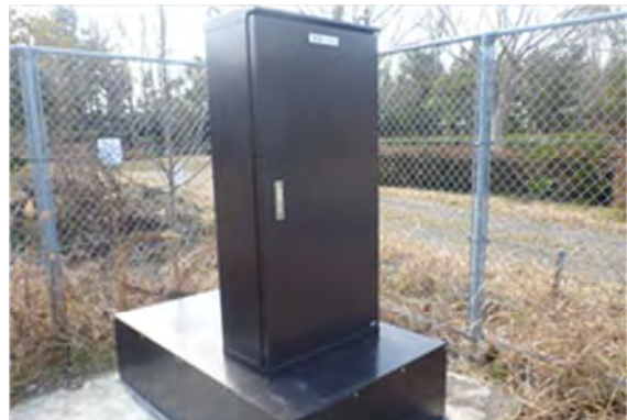
▲平成 25 年 12 月 6 日 本復旧完了
