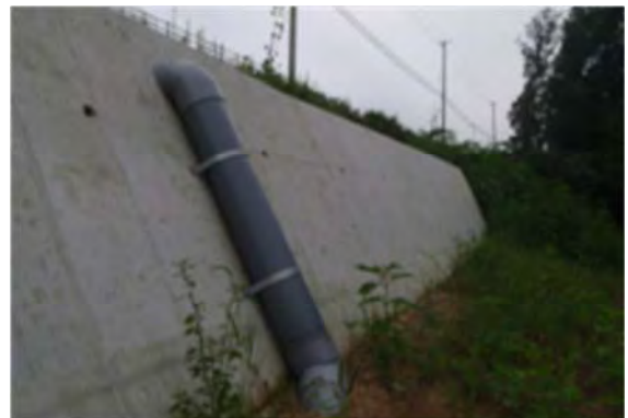
▲平成 25 年 8 月 21 日 本復旧完了
