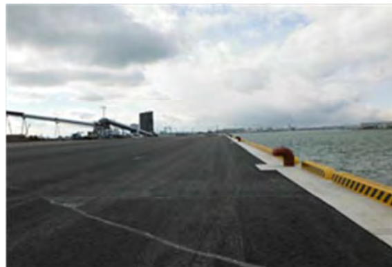
▲平成 26 年 3 月 28 日 一部荷捌地復旧完了
