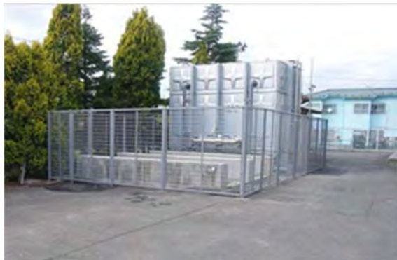
▲平成 25 年 6 月 17 日 本復旧完了 受水槽〔SUS 製〕
