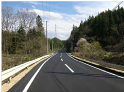
▲平成 25 年 5 月 20 日 本復旧完了
