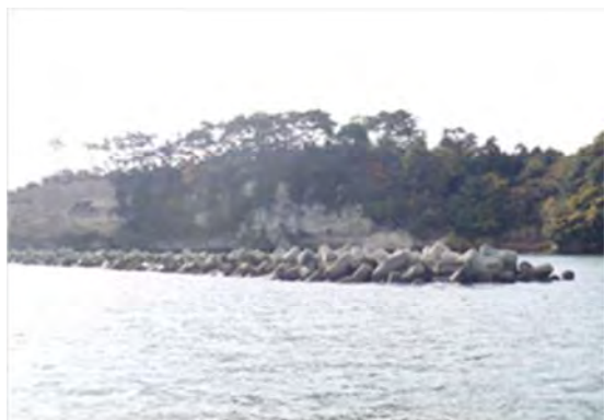
▲仙台塩釜港（塩釜港区） 石浜離岸堤
