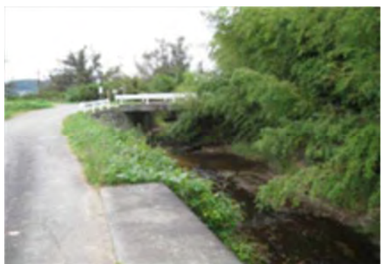
▲太田川河川改修事業 川下田橋架換工事 栗原市築館太田地内
