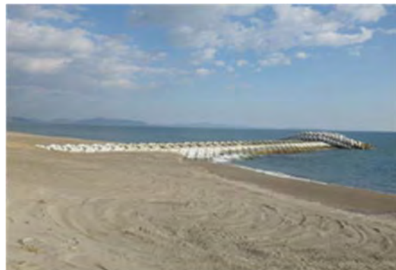
▲平成 25 年 12 月 11 日 本復旧完成
