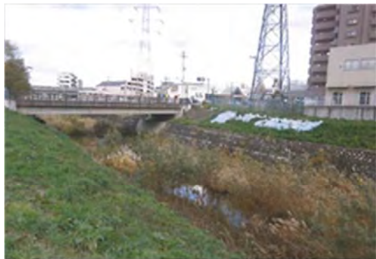
▲高柳川 仙台市泉区みずほ台地内 被災状況
