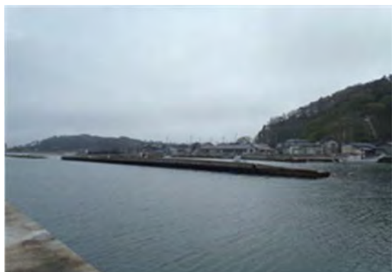
▲仙台塩釜港（塩釜港区） 代ヶ崎清水東側防波堤
