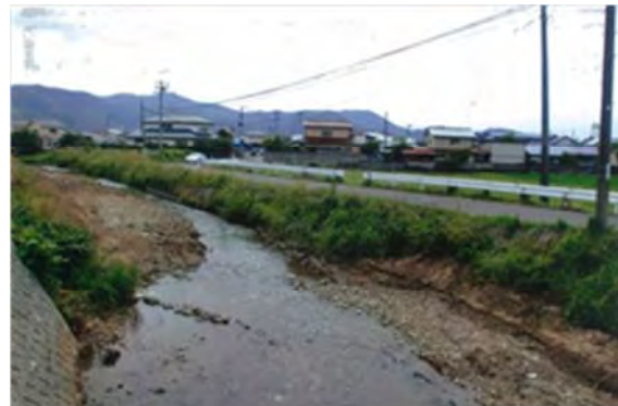
平成 26 年 1 月 29 日 河道掘削完了
