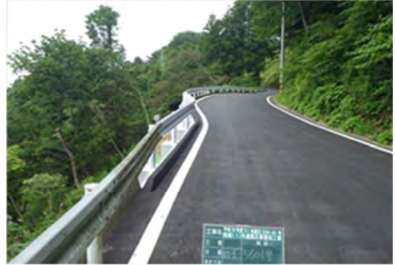
▲平成 25 年 7 月 31 日 完成 船越（1）外道路災害復旧工事
