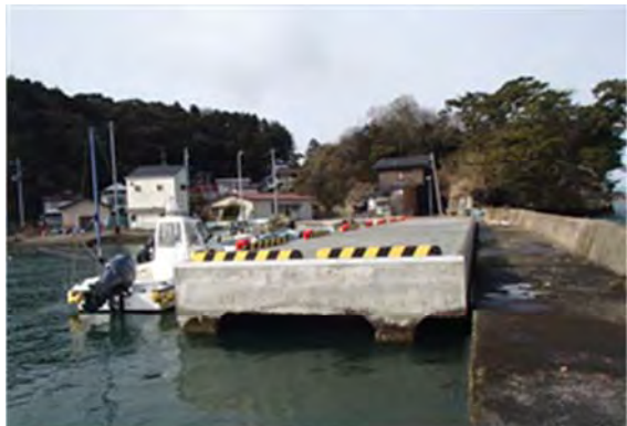
▲平成 26 年 3 月 28 日 本復旧完了
