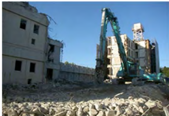
▲平成 24 年 7 月 20 日 解体着工 県営名取手倉田第二住宅 1 号棟 名取市小山地内
