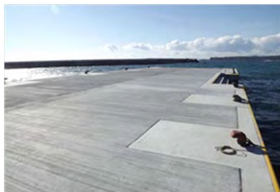
▲本復旧完了 平成 25 年 12 月
