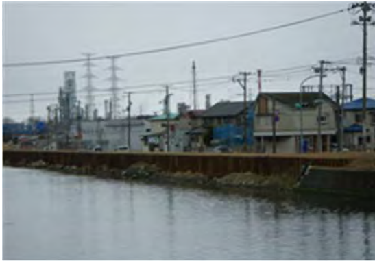
▲砂押川 多賀城市桜木地内 被災状況
