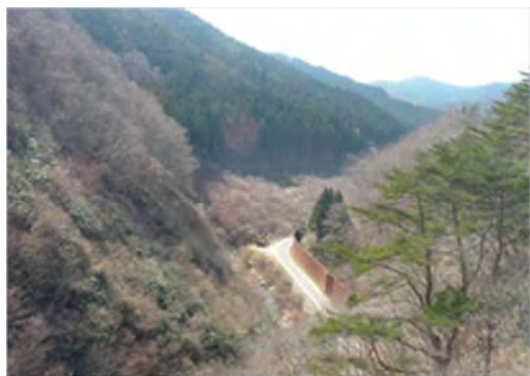
▲ 弘川ダム 南三陸町歌津字弘川地内 ダム本体工事 着手 (H21.3月)
