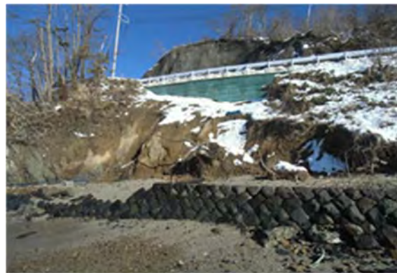
▲平成 25 年 6 月 31 日 本復旧完了
