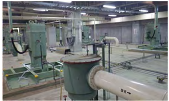
▲平成 25 年 12 月 10 日完成状況
