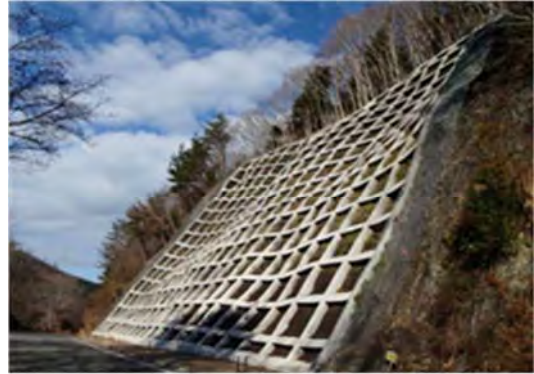
▲平成 25 年 12 月 11 日 本復旧完了
