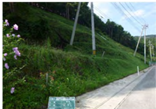
▲平成 26 年 1 月 8 日 本復旧完了
