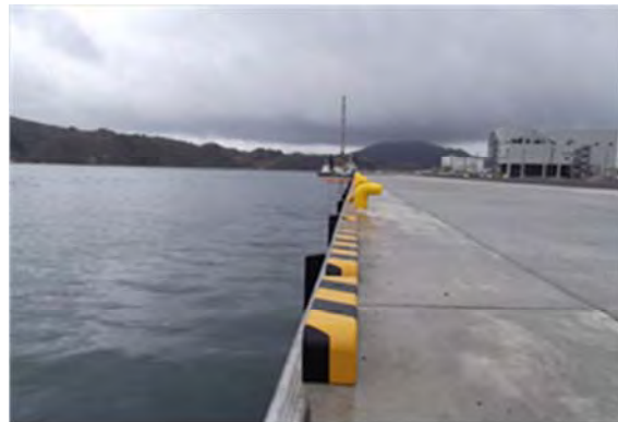
▲本復旧完了 平成 25 年 12 月
