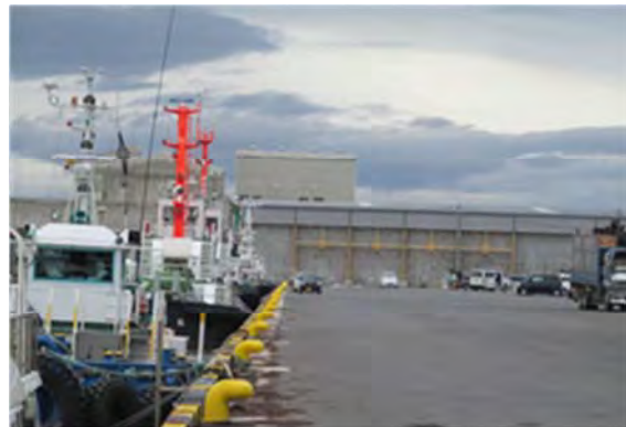
▲本復旧完了 平成 25 年 12 月 27 日
