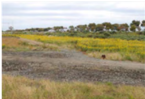
▲川内沢川（放水路） 名取市植松地内 分水路工
