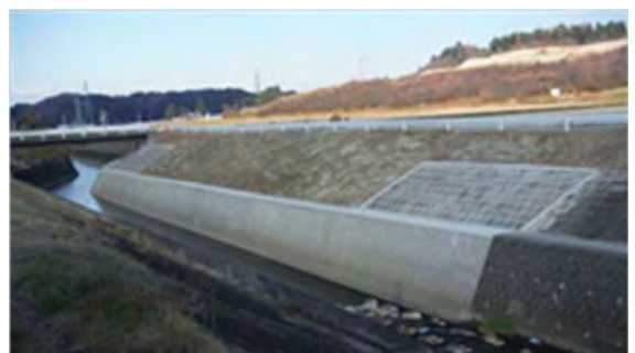
▲平成 26 年 3 月 20 日 本復旧完了
