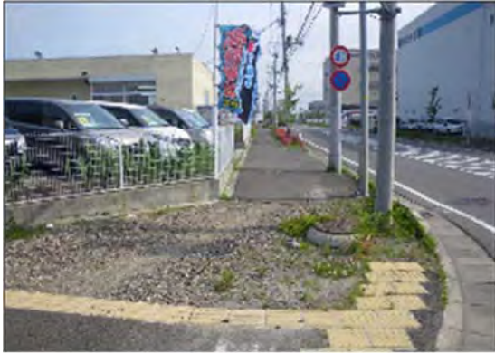
▲地震により隆起したマンホール (ポートセンター南線)
