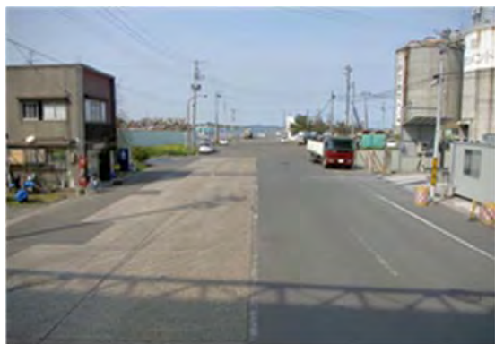
▲臨港道路貞山ふ頭 1 号線 塩竈市地内
