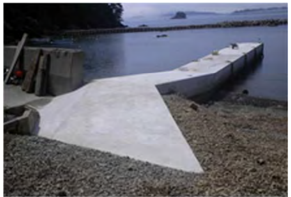
▲平成 26 年 2 月 3 日 完成 唐桑海岸 栢浜地区海岸 突堤(1)
