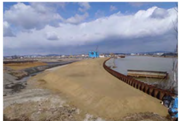
▲平成 26 年 3 月 14 日 築堤盛土(暫定)完成
