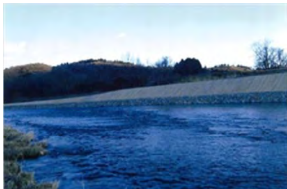
平成 26 年 1 月 29 日 白石川河岸復旧完了
