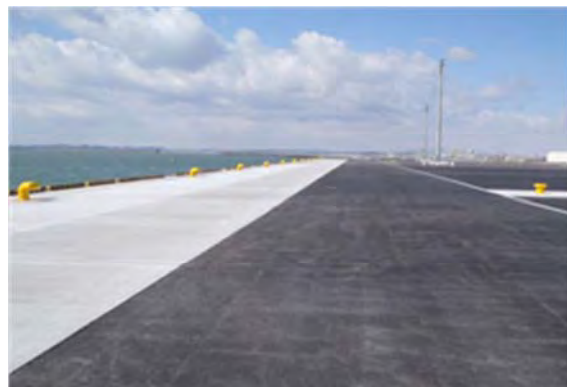
▲本復旧完了 平成 26 年 1 月 31 日
