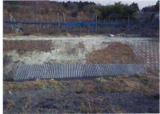
▲平成 25 年 7 月 3 日 本復旧完了
