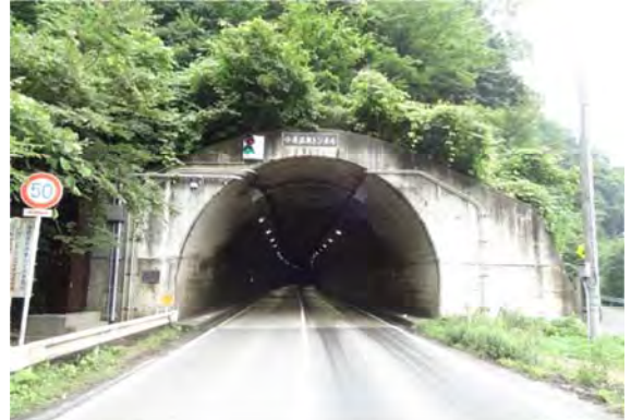
▲平成25年7月30日 トンネル照明設備更新完了
