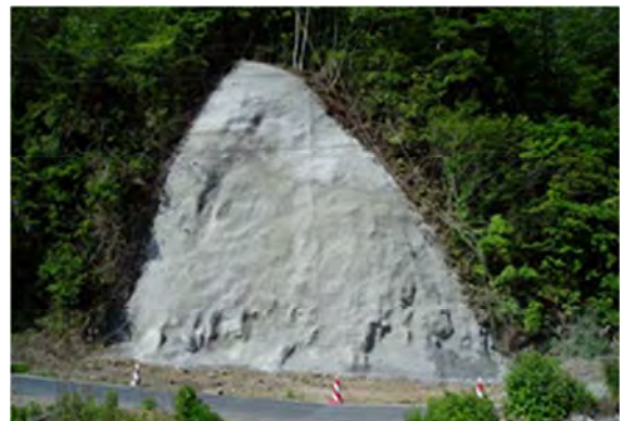
▲平成 25 年 5 月 30 日 吹付工完了
