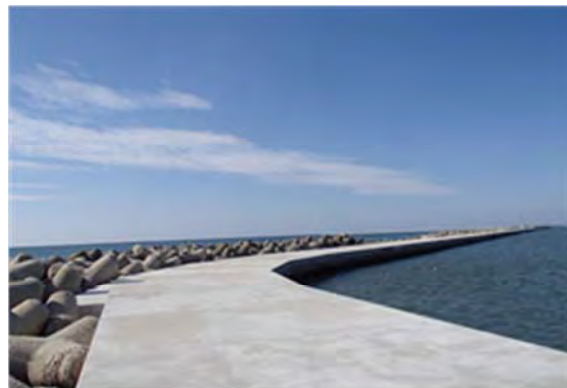
▲本復旧完了 平成 25 年 5 月 31 日
