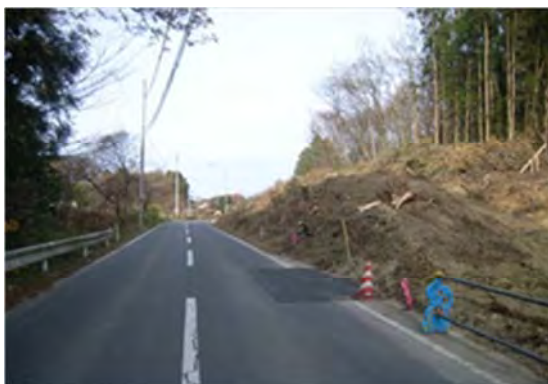
▲（主）河南築館線 栗原市瀬峰清水沢地内 清水沢道路改良事業
