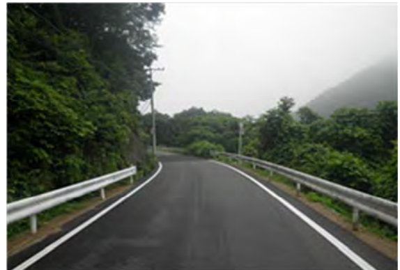
▲平成 25 年 10 月 25 日 本復旧完了
