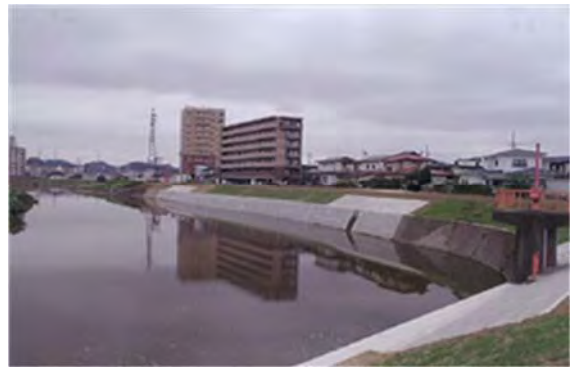
▲平成 25 年 7 月 18 日 本復旧完了
