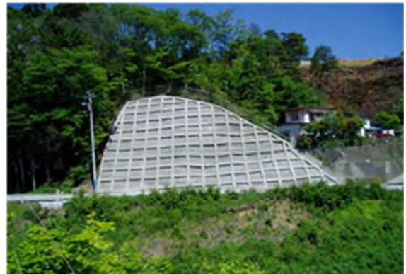
▲平成 25 年 5 月 20 日 吹付法枠工完了
