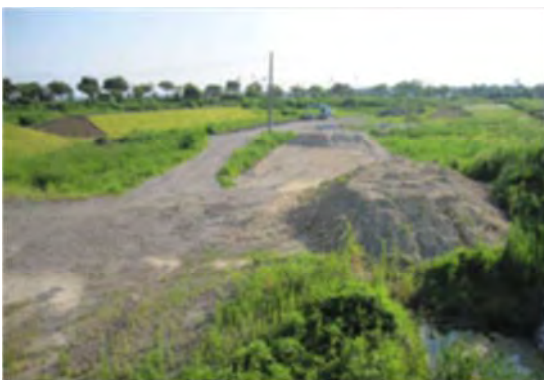
▲川内沢川（放水路） 名取市植松地内 放水路掘削築堤・護岸工事
