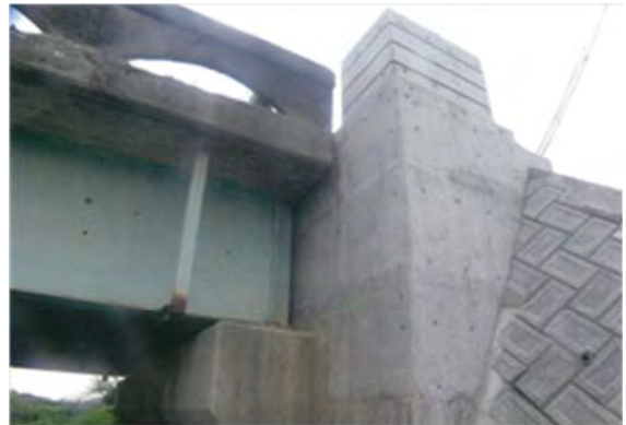
▲平成25年8月29日日本復旧完了
