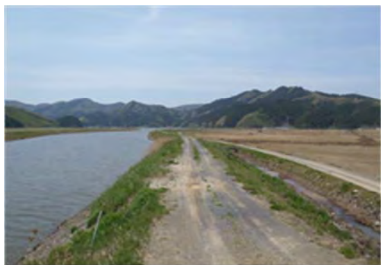
▲平成 25 年 4 月 24 日着工 富士川河川災害復旧工事 石巻市針岡地内
