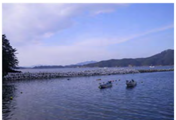
▲平成 26 年 2 月 3 日 完成 唐桑海岸 栢浜地区海岸 突堤(2)
