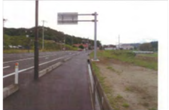
▲平成 25 年 6 月 28 日 本復旧完了
