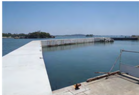
▲平成 26 年 3 月 28 日 本復旧完了
