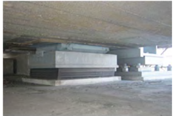
▲平成 26 年 2 月 13 日 本復旧完了
