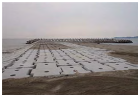
▲平成 26 年 3 月 13 日 本復旧完成
