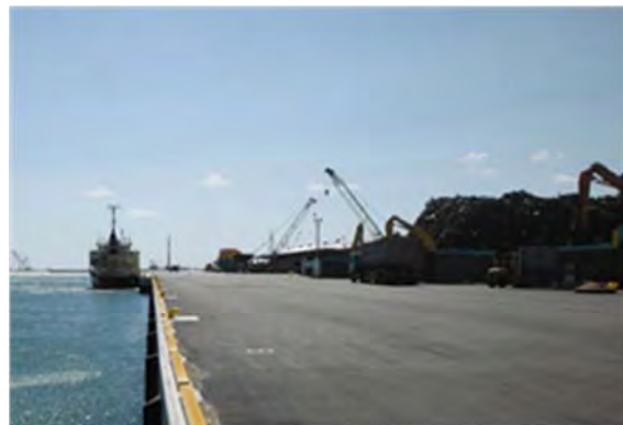
▲本復旧完了 平成 26 年 3 月 28 日
