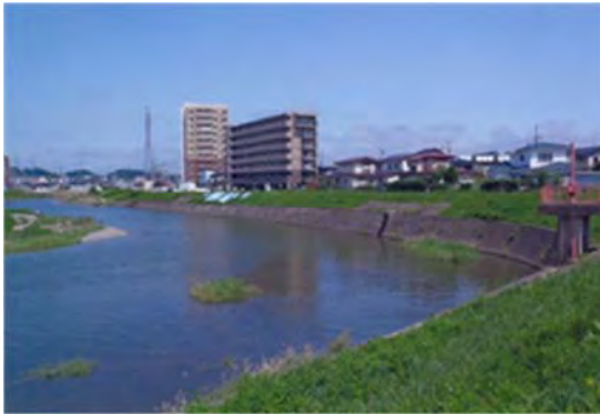
▲七北田川 仙台市泉区八乙女地内 被災状況
