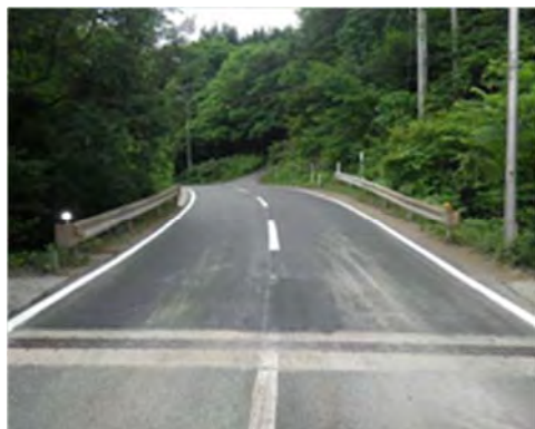
▲平成 25 年 9 月 19 日 本復旧完了
