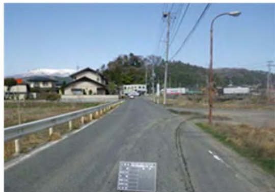
平家川 橋梁下部工・護岸 着工前
