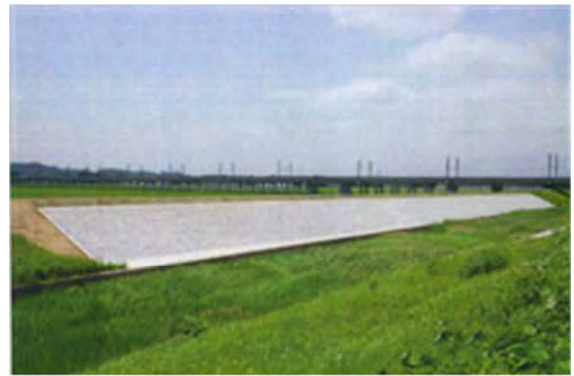
▲平成 25 年 7 月 25 日 本復旧完了
