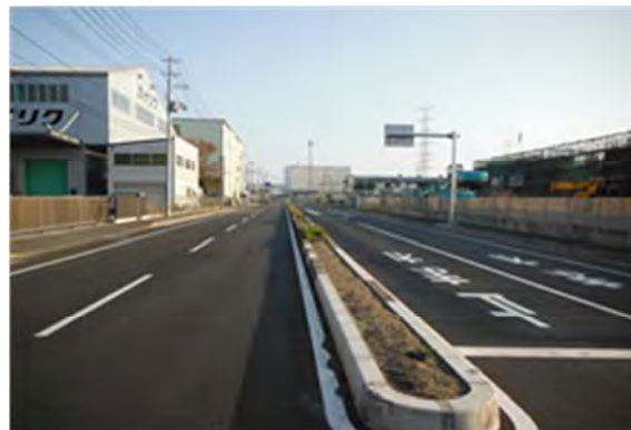
▲平成 25 年 8 月 26 日 本復旧完了
