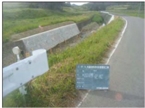
▲平成25年6月4日 本復旧完了
