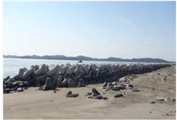
▲平成 26 年 3 月 13 日 本復旧完成
