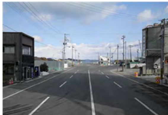
▲平成 26 年 2 月 26 日 本復旧完了
