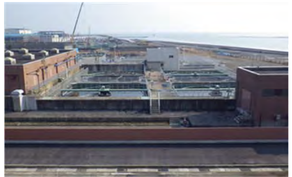
▲平成 26 年 3 月 26 日完成状況
