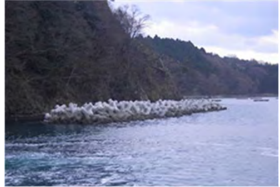
▲平成 26 年 2 月 3 日 完成 唐桑海岸 藤浜地区海岸 離岸堤(1)
