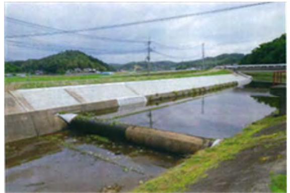
▲平成 25 年 7 月 25 日 本復旧完了
