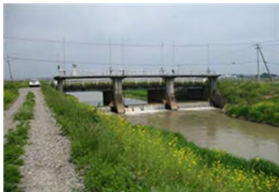
▲落堀川河川改修事業 新田橋架換工事 栗原市若柳川南北谷地地内
