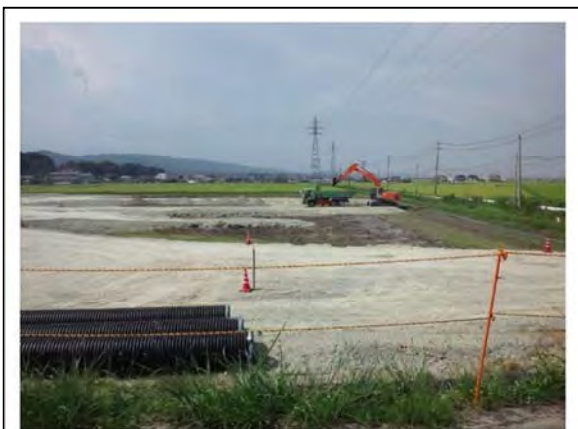
▲平成 25 年 11 月 20 日着工 山元町新山下駅周辺地区(第 1 期)災害公営住宅
