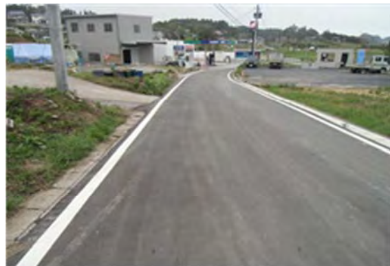
▲平成 25 年 6 月 3 日 本復旧完了
