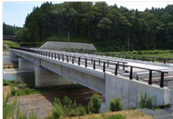
▲桜子大橋” 本体工成 平成 25 年 7 月
