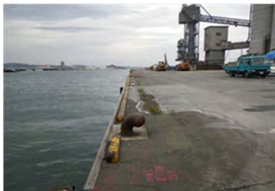
▲仙台塩釜港（塩釜港区） 東ふ頭岸壁
