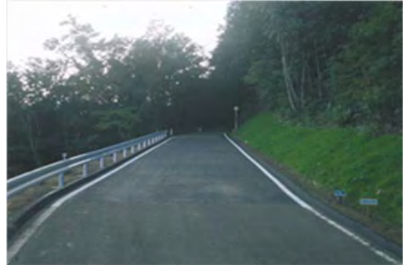
▲平成 25 年 10 月 21 日 本復旧完了
