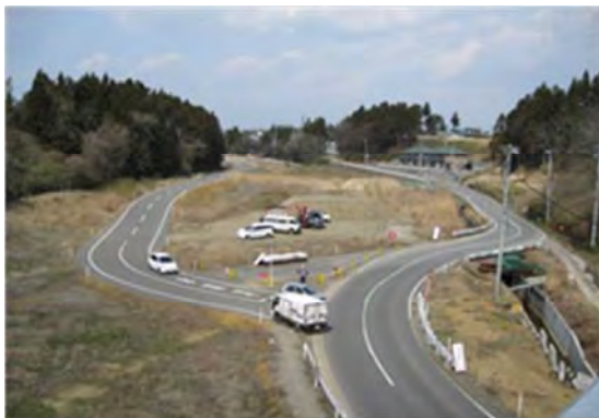
▲（都）源光町田線 栗原市築館内沢地内 内沢道路改築事業
