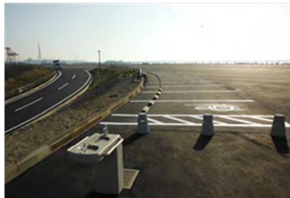
▲平成 25 年 8 月 26 日 本復旧完了
