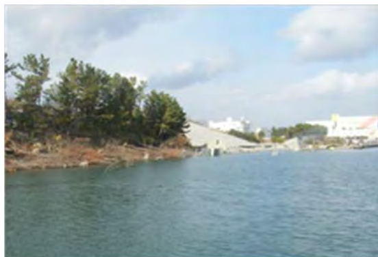
▲平成 24 年 11 月 2 日着工 仙台塩釜港（仙台港区） 雷神護岸 I 災害復旧工事
