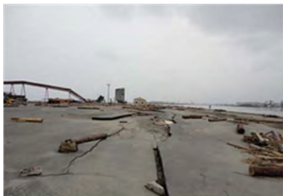
▲南浜岸壁・荷捌地被災状況 平成 23 年 3 月 15 日
