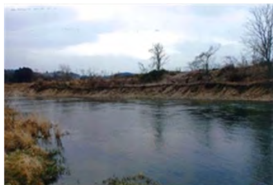
白石川河岸浸食状況
