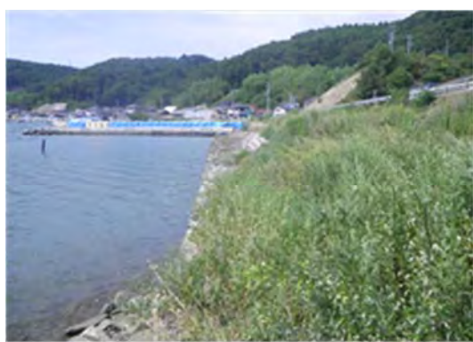
▲平成 24 年 8 月 9 日着工 折立海岸災害復旧工事 石巻市沢田地内
