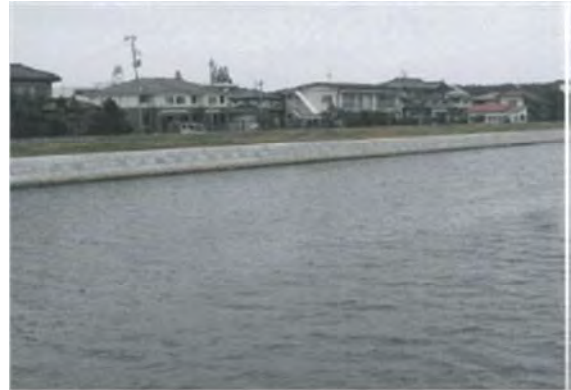
▲平成 25 年 9 月 30 日 本復旧完了
