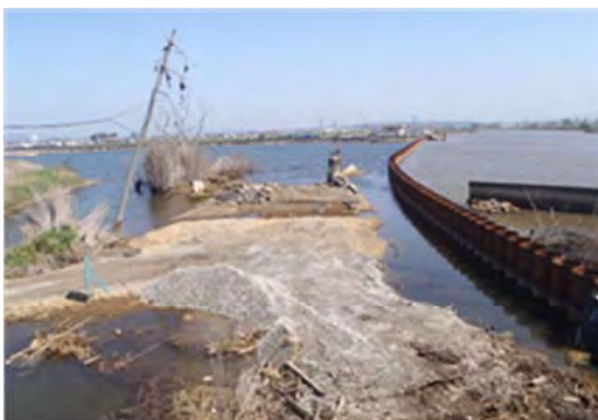
▲定川 東松島市大曲字道下地内 定川波堤状況
