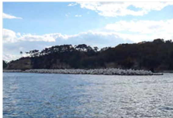
▲平成 26 年 3 月 28 日 本復旧完了
