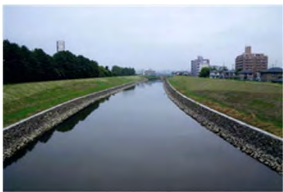
▲平成 25 年 7 月 24 日 本復旧完了
