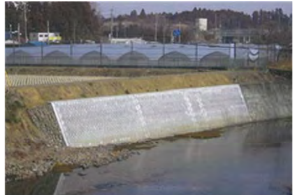
▲平成 26 年 2 月 21 日 本復旧完了
