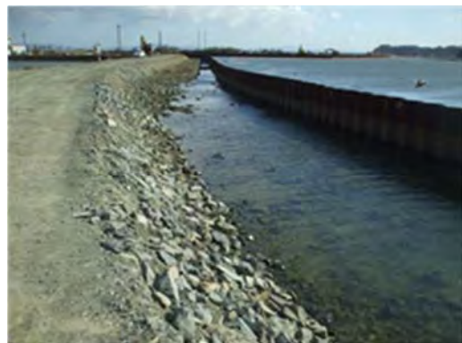
▲平成 26 年 3 月 25 日 本復旧完了
