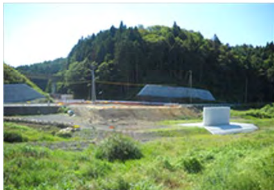
▲国道 346 号 気仙沼市本吉町津谷桜子地内 “桜子大橋” 着工前状況
