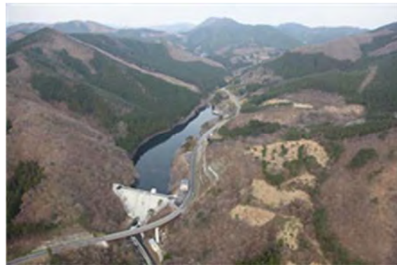
▲ 弘川ダム完成 平成 25 年 4 月
