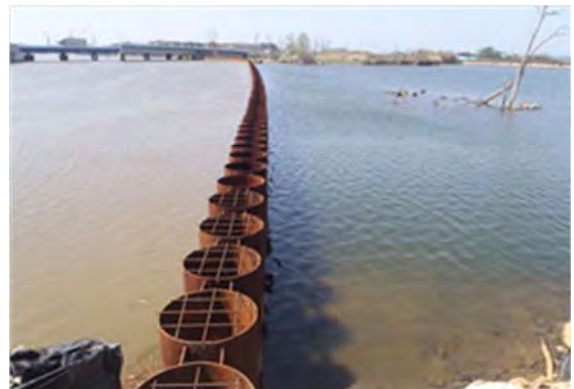
▲平成 25 年 5 月 22 日 鋼管杭打設完成
