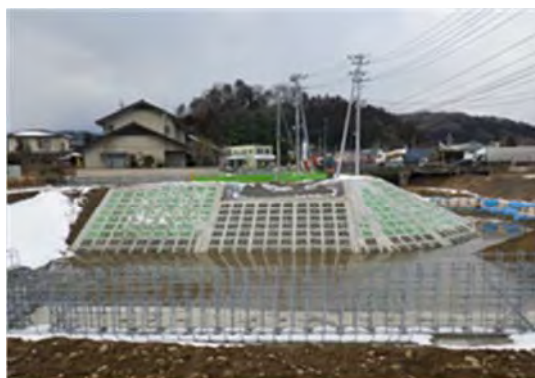
平成 26 年 2 月 28 日 平家川橋梁下部工・護岸完了
