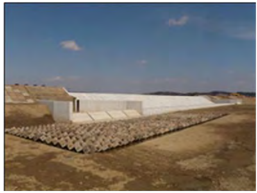
▲平成26年3月25日 本復旧完了
