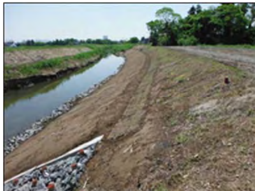
▲平成25年5月27日 本復旧完了
