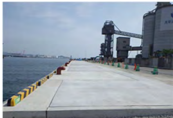
▲平成 28 年 3 月 28 日 本復旧完了
