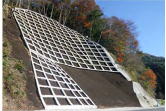
▲平成 25 年 12 月 5 日 本復旧完了
