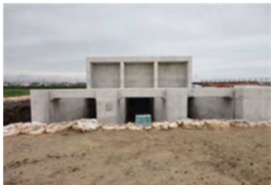
▲川内沢川（放水路） 名取市杉ヶ袋地内 八間堀サイフォン除塵機・ゲート設備工事
