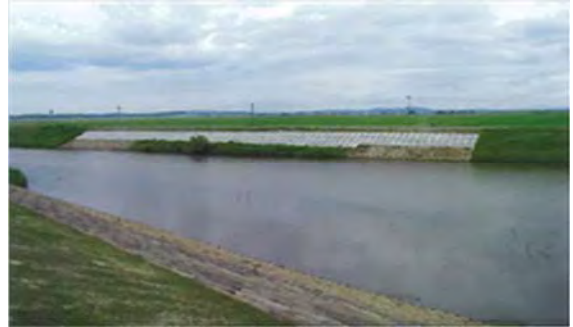
▲平成 25 年 6 月 26 日 本復旧完了
