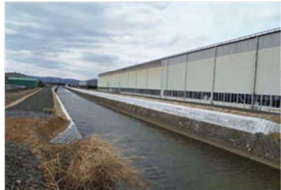
▲平成 26 年 3 月 26 日 本復旧完了
