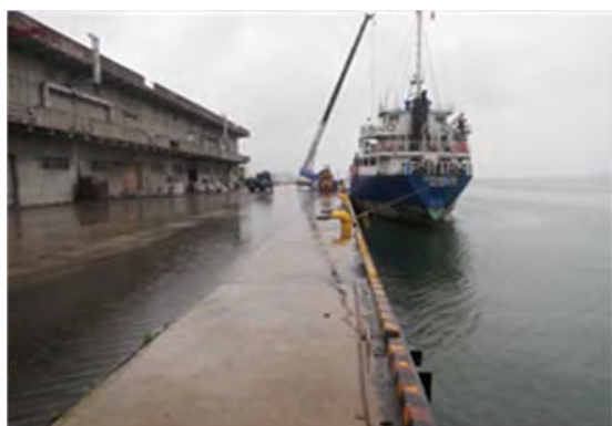
▲平成 24 年 4 月 20 日着工 仙台塩釜港（塩釜港区） 貞山 2 号岸壁災害復旧工事
