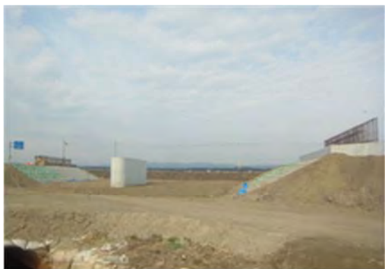
▲川内沢川（放水路） 岩沼市下野郷地内 （主）塩釜互理線 矢野目新橋上部工工事
