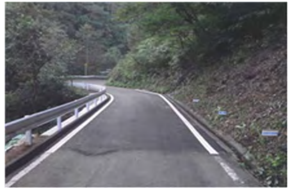
▲平成 25 年 10 月 21 日 本復旧完了
