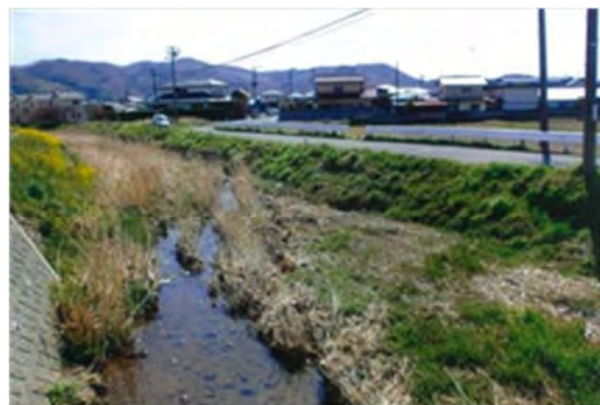
天津沢川河道土砂堆積状況
