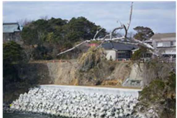
▲平成 26 年 3 月 24 日 本復旧完了
