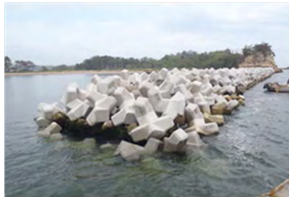
▲平成 25 年 8 月 25 日 本復旧完了
