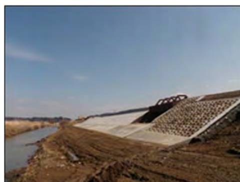
▲平成26年3月25日 本復旧完了
