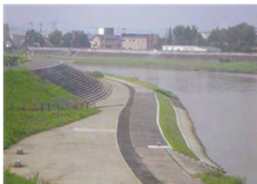
▲平成 25 年 8 月 21 日 本復旧完了
