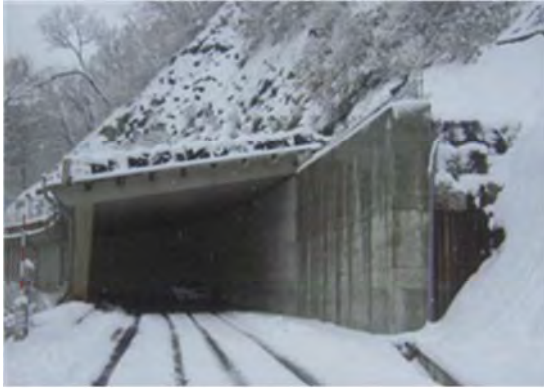
▲(国) 398号 栗原市花山本沢岳山地内 湯浜スノーシェッド(上部工)工事
