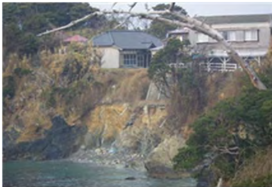
▲網地地区海岸 石巻市長渡浜地内外 被災状況
