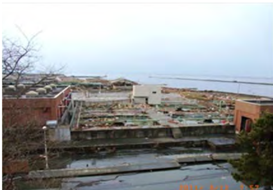
▲平成 23 年 3 月 12 日被災状況 石巻東部浄化センター 2 系水処理施設最終沈殿池
